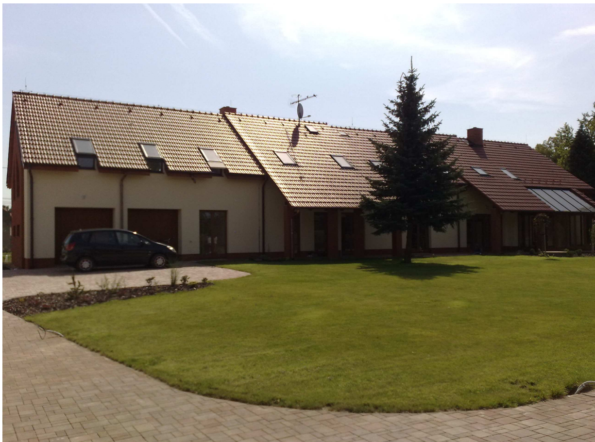
Obr. 4.2 -1 Pohled na realizovanou stavbu
