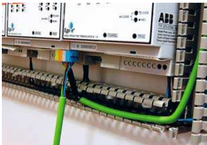
Obr. 2.2.3 -2 Připojení prvků v rozváděči primární sběrnici[1]
