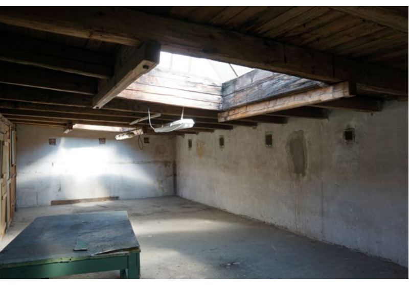
8 Půdní prostor s havarijním stavem nosných konstrukcí
