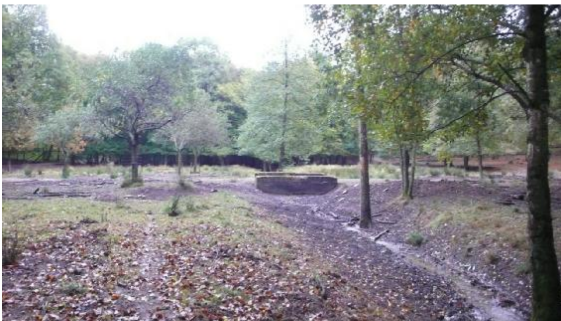
Obr. B.1 Pohled na staveniště z prostoru usazovací průtočné vodní tůně
