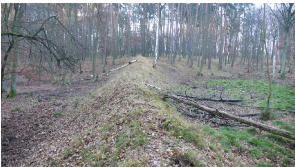
Obr. B.6 Pohled na stávající ochrannou hrázku
