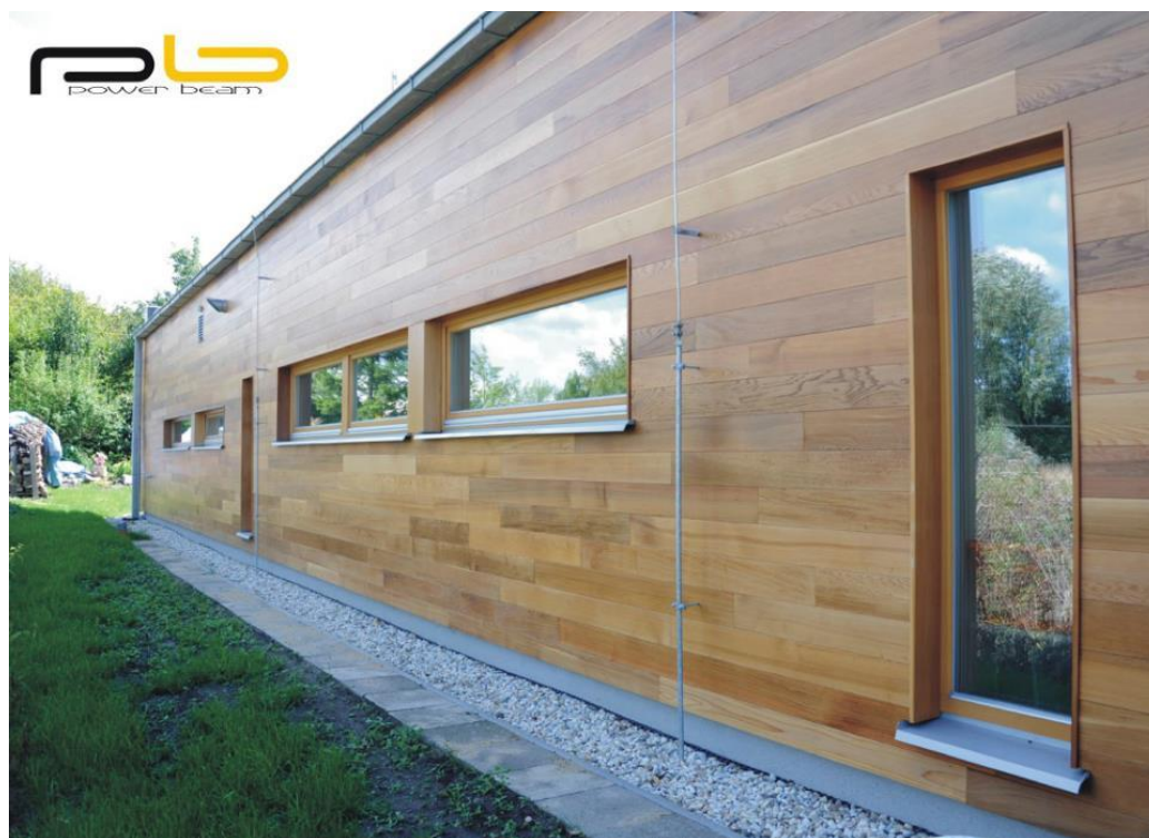
Obr. 1 - Dřevěná provětrávaná fasáda – Cedrové dřevo [5]
