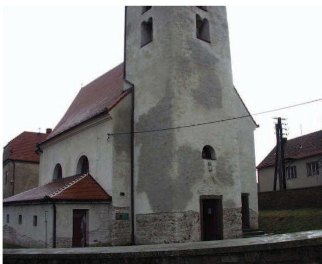
Obr. 4 - Kostel v Lukovanech – obnova fasády za použití omítky s malým množstvím cementu (foto P. Rovnaníková)
