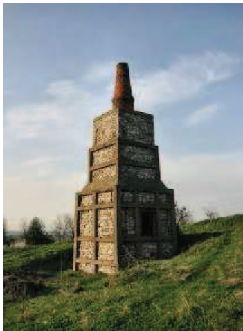
Obr. 13 - Šachtová pec, Bystré u Poličky [32]
