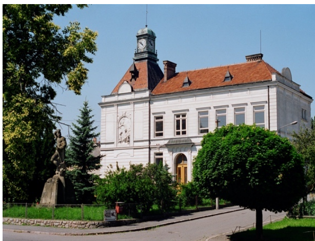
Obrázek 30: ZŠ Dolní Újezd Zdroj: www.cestamipromen.cz
