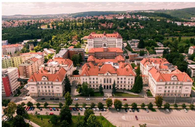
Obrázek 33: Areál fakulty stavební VUT v Brně Zdroj: www.cz.linkedin.com/school/fastvut
