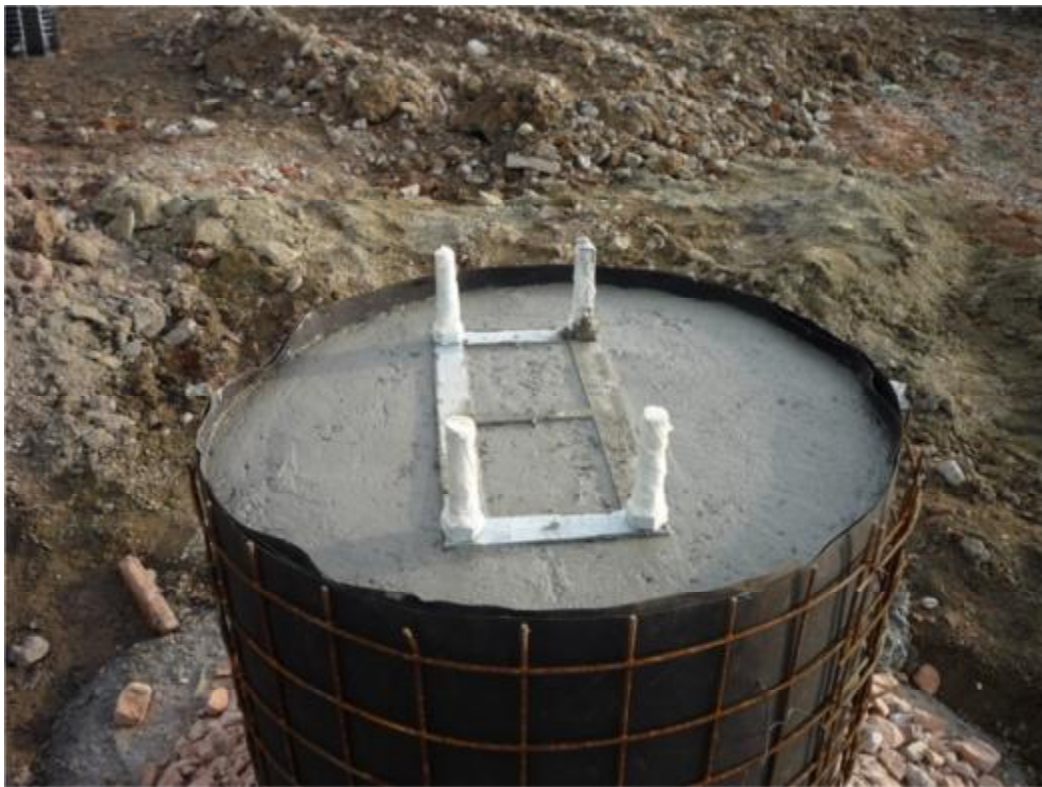
Zalítý kotevní blok
