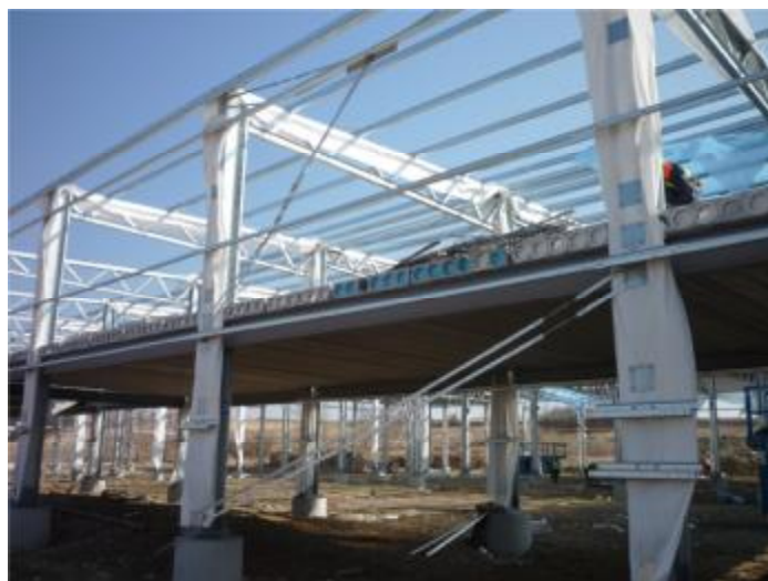
Pohled na namontovaný spirolový strop
