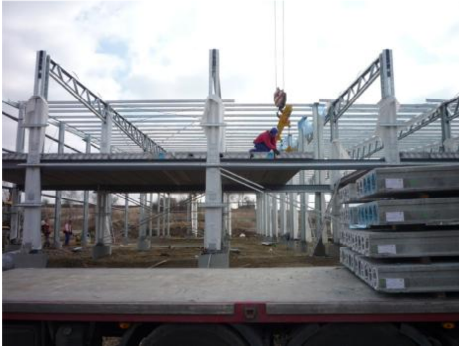
Skládání ŽB panelů typu Spiroll z návěsu
