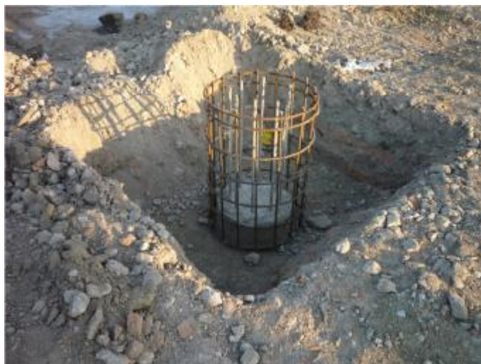
Rozšíření zhlaví piloty na D=90 cm
