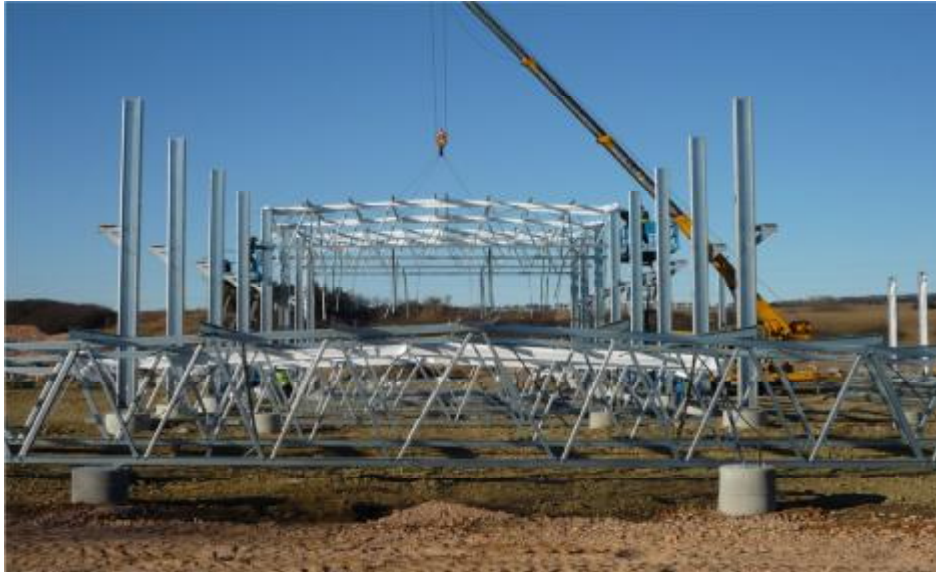
Osazování střešních vazníků středové části haly
