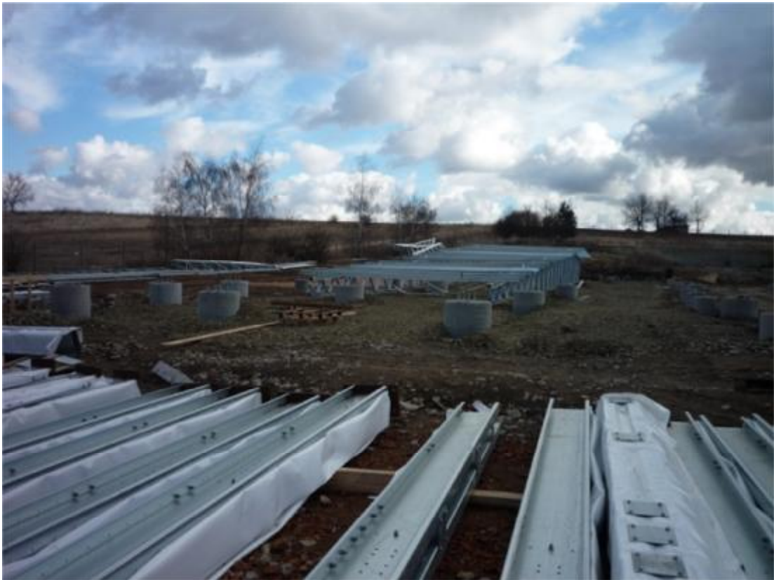
Skládka dílců ocelové konstrukce
