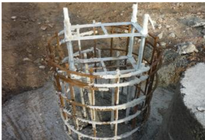
Osazený kotevní blok do rozšířeného zhlaví piloty D=90 cm
