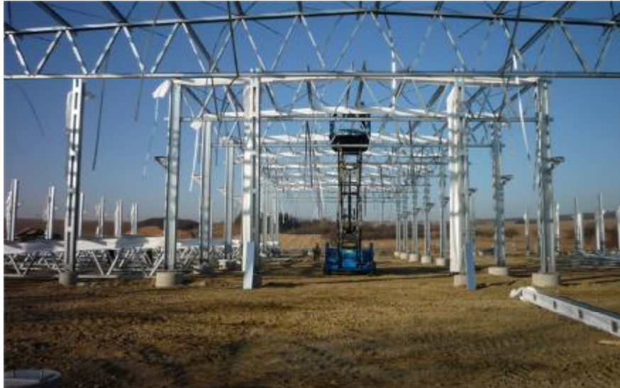
Pohled na částečně namontovanou ocelovou konstrukci
