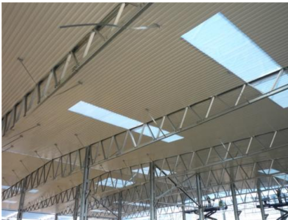
Podhled a prosvětlovací pásy haly
