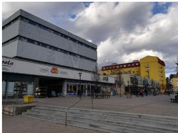
Obrázek 17: Pohled na severní stranu Zdroj: Autor práce
