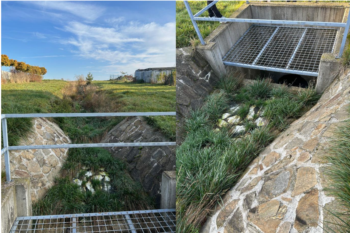
Obr. 21 – Pohled na svodný průleh (vlevo), horská vpust (vpravo)
