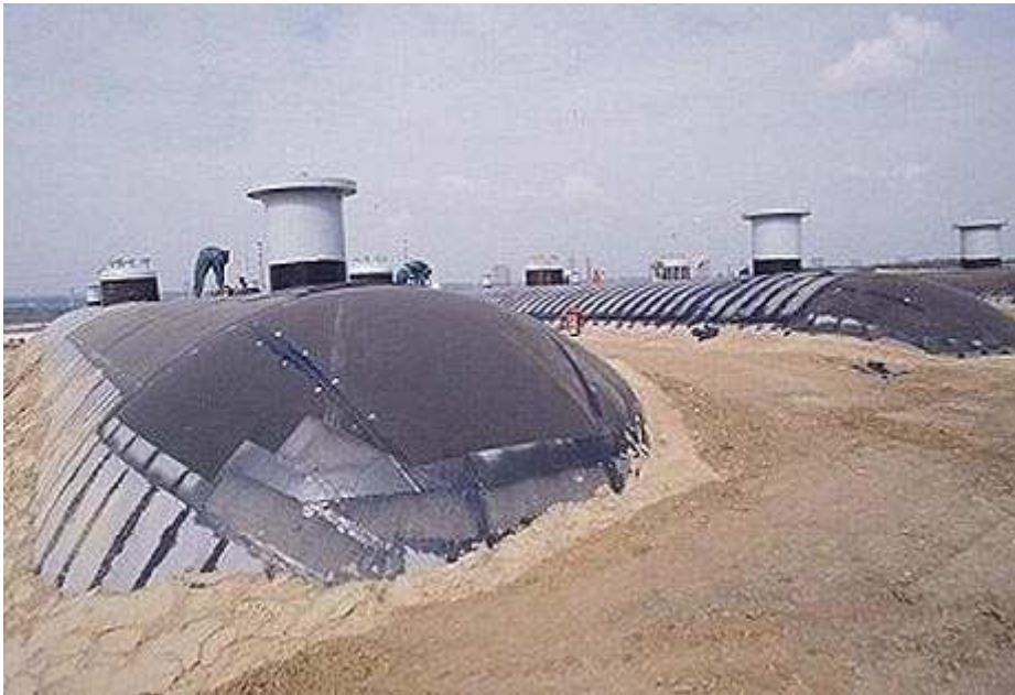
Obrázek 3.5 Horizontální válcová nádrž zasypaná [10]
