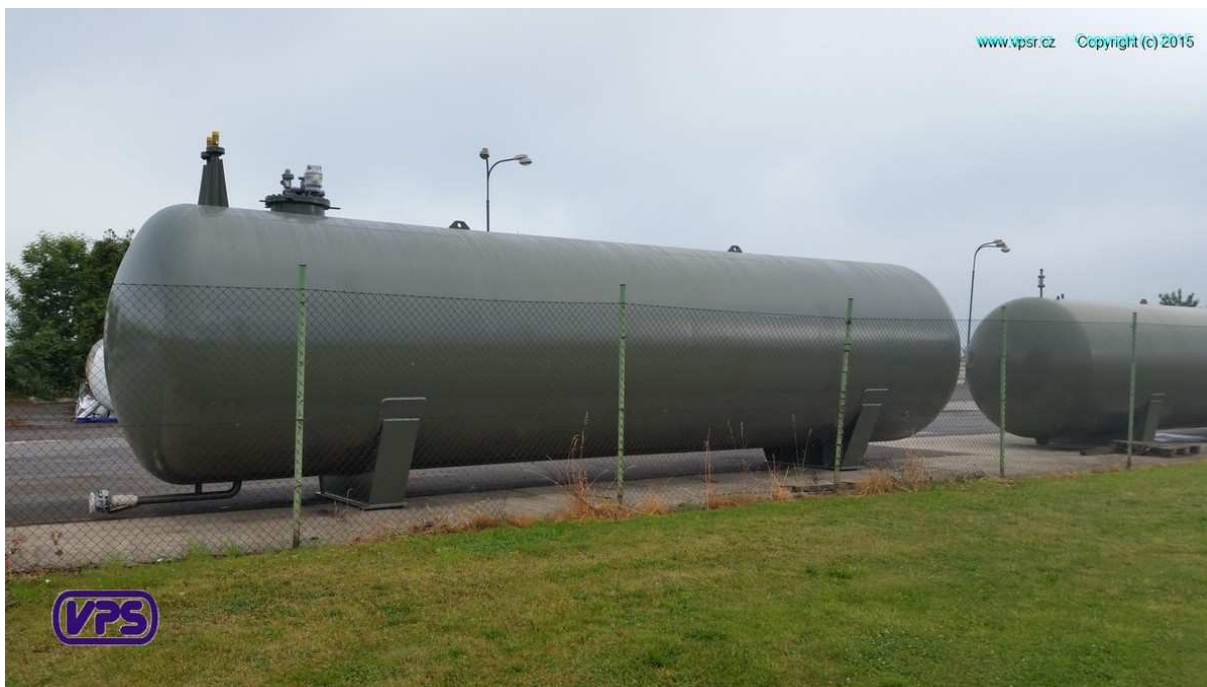
Obrázek 3.4 Horizontální válcová nádrž se sedlovou podporou [8]
