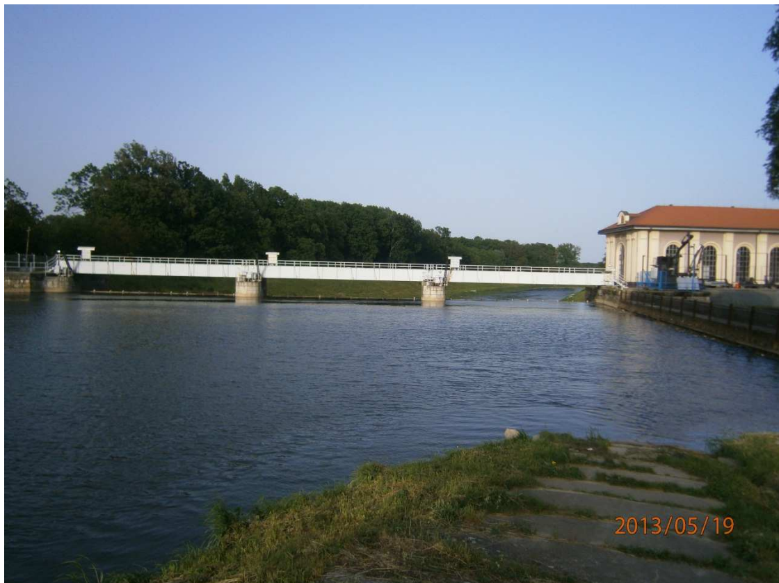
Obrázek 18: kroměřížský jez, pohled z pravého břehu řeky Moravy na těleso jezu a budovu MVE
