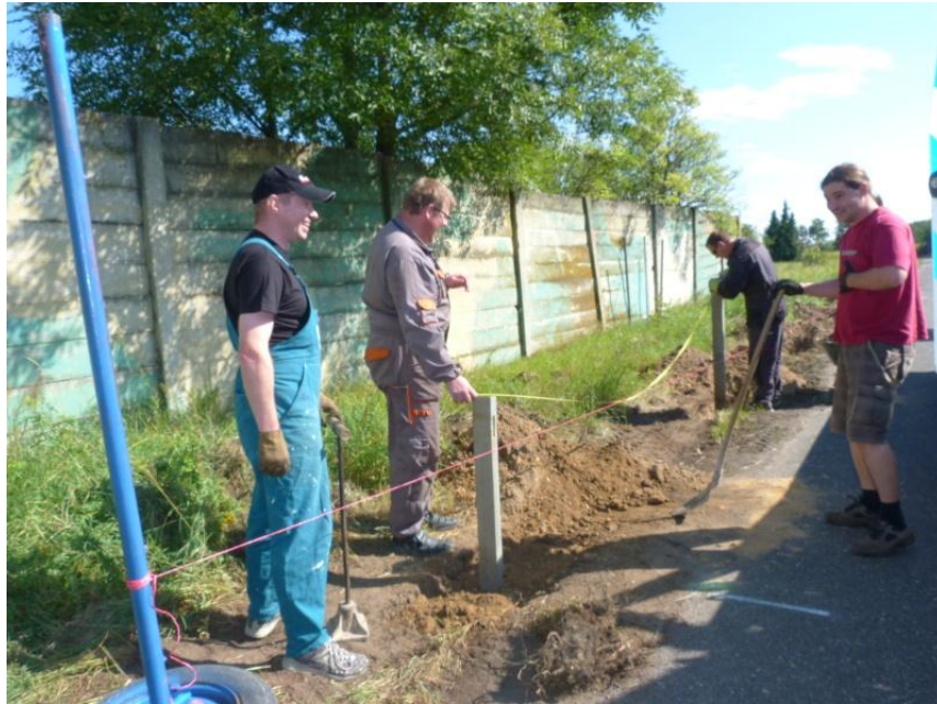
Obrázek č. 4 – Montáž svodidel.
