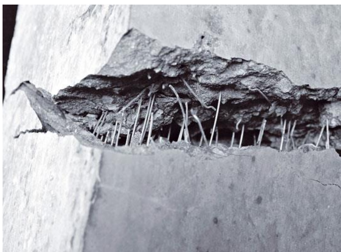
Obrázek 14: Beton s rozptýlenou výztuží [18]
