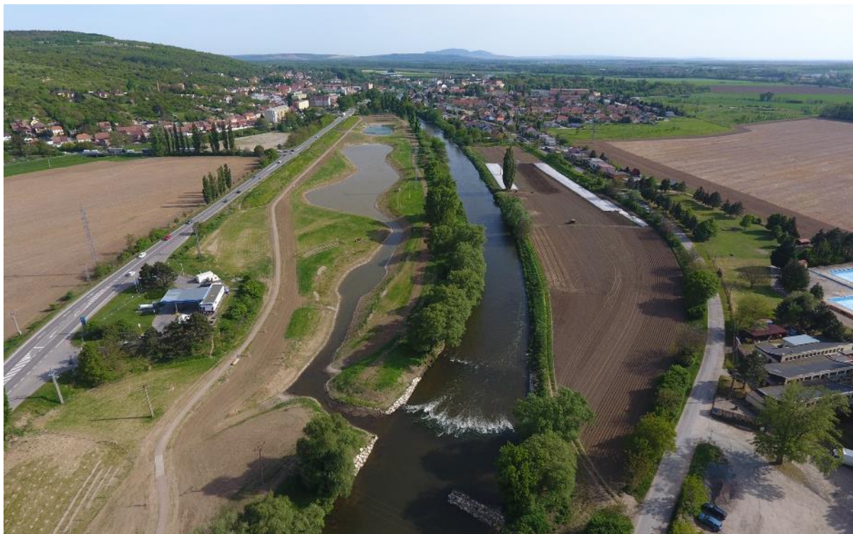
Obrázek 4 – Akce: Svatka nad Židlochovicemi Povodňový park, stav území 29. 4. 2024 po dokončení stavby (zdroj: foto Michal Soope 2024)
