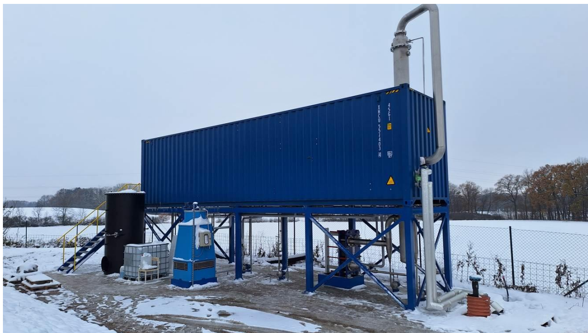
Obr. 26: Fotografie prototypu velkokapacitní zahušťovací technologie v BPS Dříteč.
