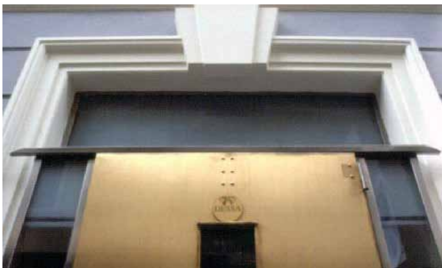
Detail vstupních dveří
