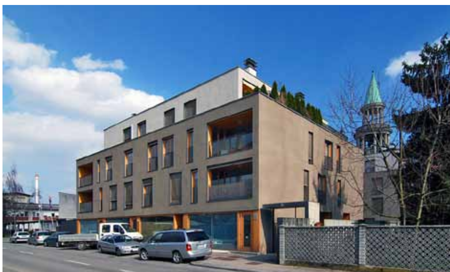
Dům za Plečnikovým kostelem sv. Františka nabízí ve dvou objektech 47 bytů a 4 obchody
