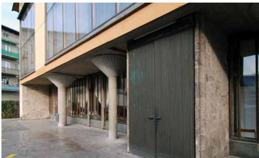
Prosklená přízemní část s mohutnými vstupními dveřmi a hříbovými hlavice železobetonových sloupů
