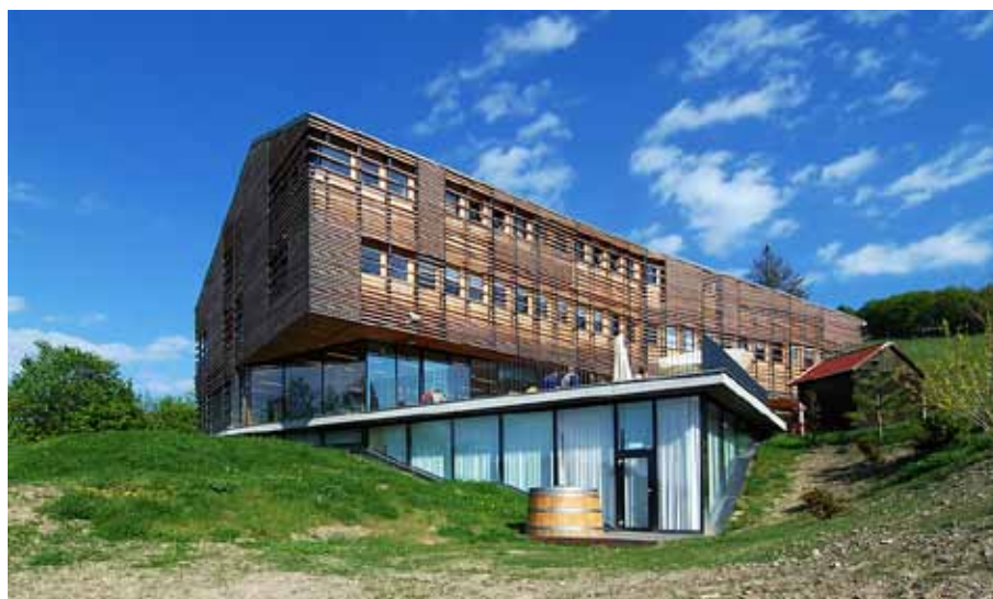
Stavba stupňovitě kopíruje klesající svah.
