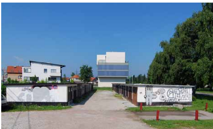
Východní fasáda domu s původními hromadnými garážemi před ním
