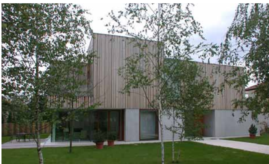
Klidové dřevěné boxy nad společenskou zónou v přízemí
