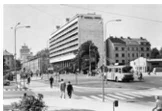
Edo Mihevc: Bytový dům Kozolec na Slovenske cestě, Lublaň 1957
