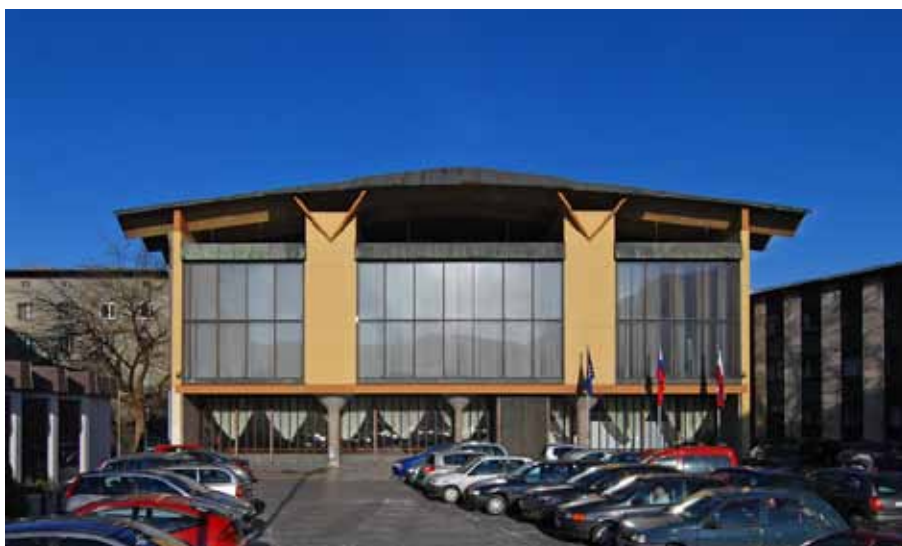
Pohled na severní průčelí zasedacího sálu
