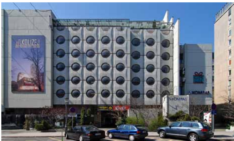
Východní fasáda parkovacího domu s čochovitými okny
