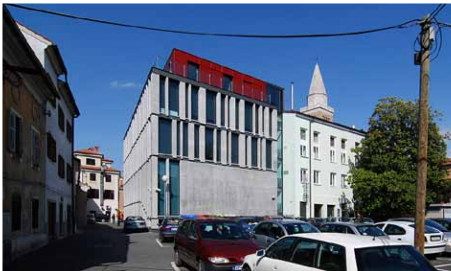
Nová přístavba v centru středověkého města
