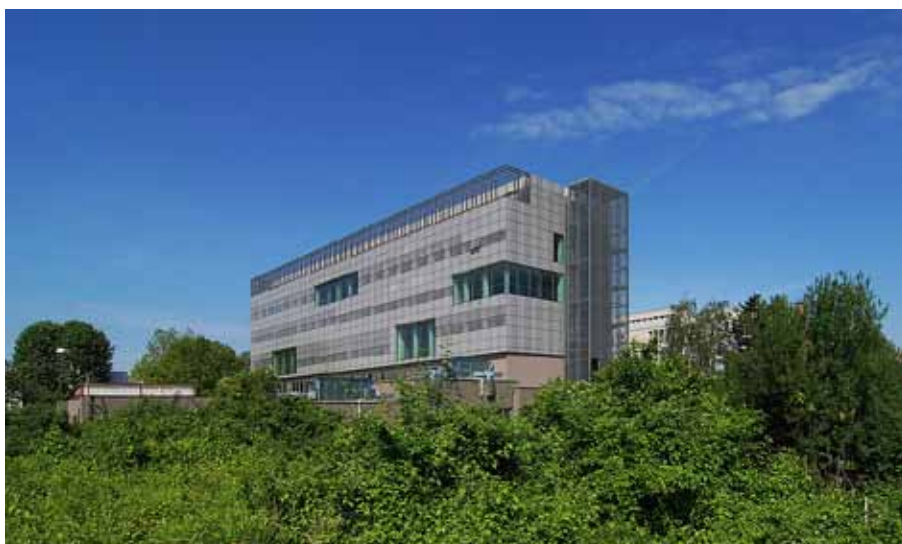
Potíštěný skleněný plášť matematické fakulty s přidruženým únikovým schodištěm
