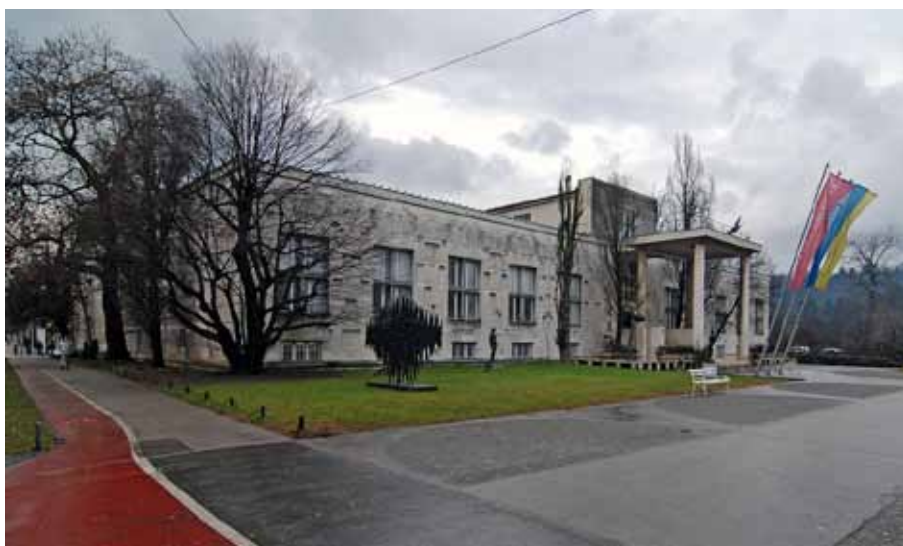
Pohled na hlavní vstup krytý baldachýnem
