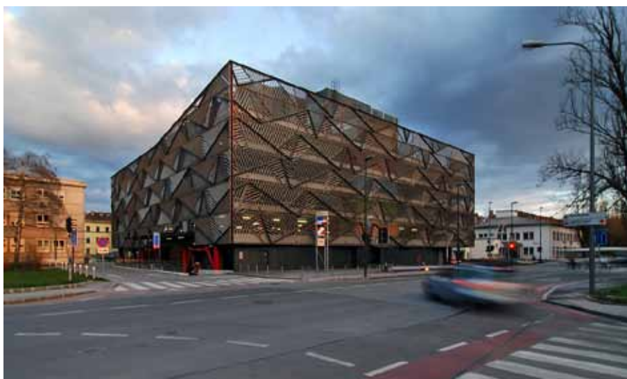
Kovová fasáda parkovacího domu obráceného do Chorvatského náměstí
