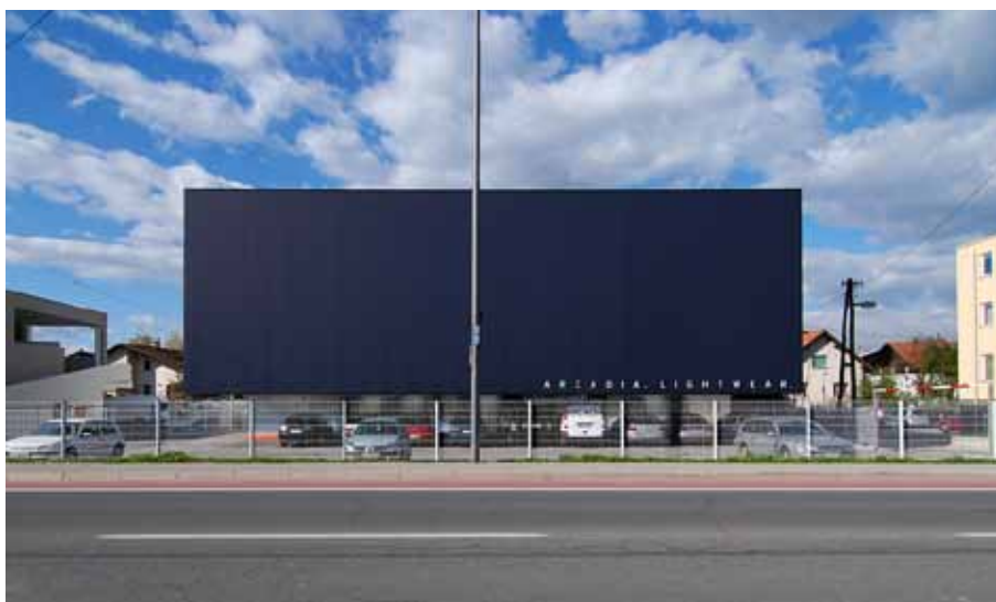
Uzavřený černý kvádr vznášející se nad parkovacím stáním pro zákazníky
