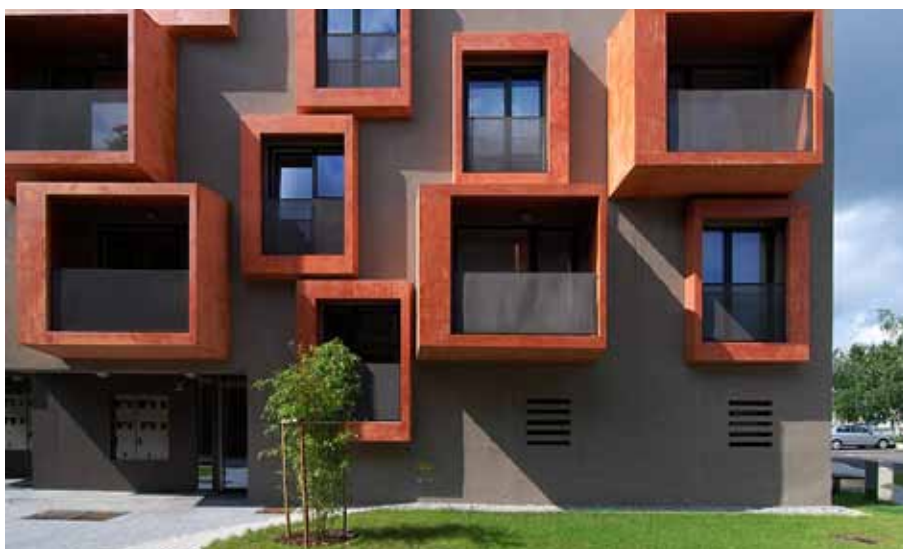
Detail výrazně plastické fasády ve vnitřním dvoře
