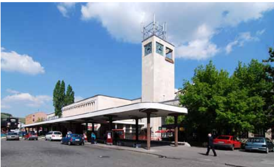
Lehký přístřešek na ocelových sloupech s hřibovými hlavicemi
