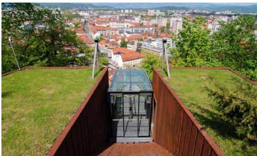
Cílová stanice pod základy hradu
