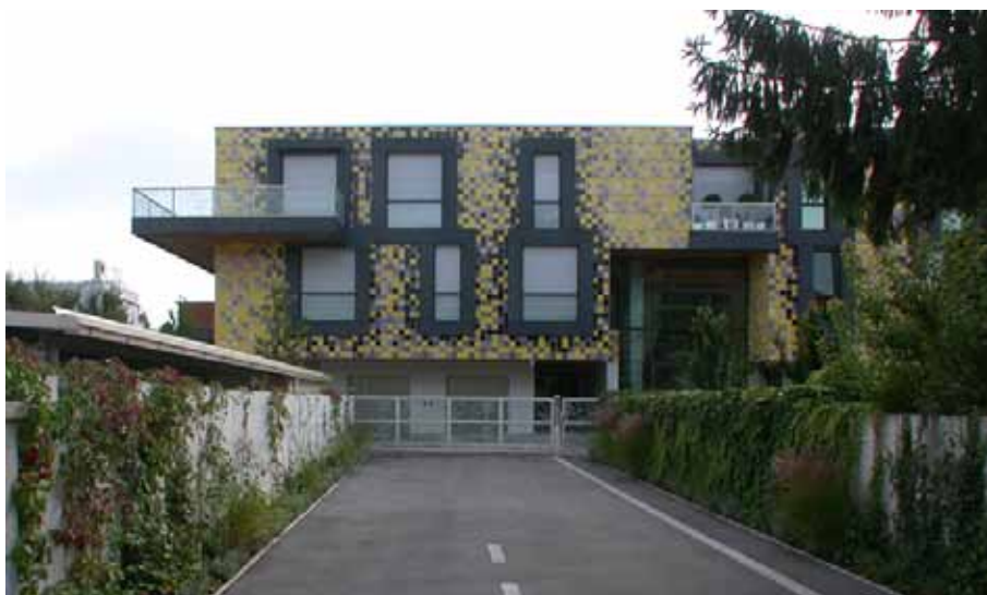
Příjezdová cesta k bytovému domu. Po levé straně jsou krytá parkovací stání
