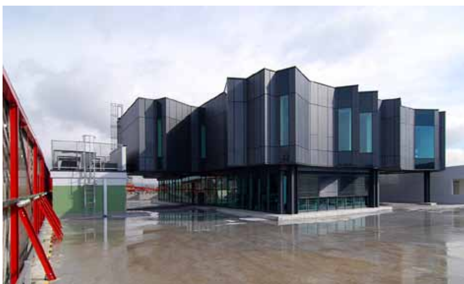
Střešní nástavba s administrativní částí
