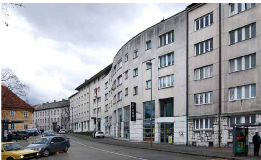
Dynamicky zvlněná fasáda domu do ulice Poljanska
