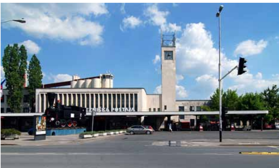
Západní fasáda s hlavním vstupem do nádraží
