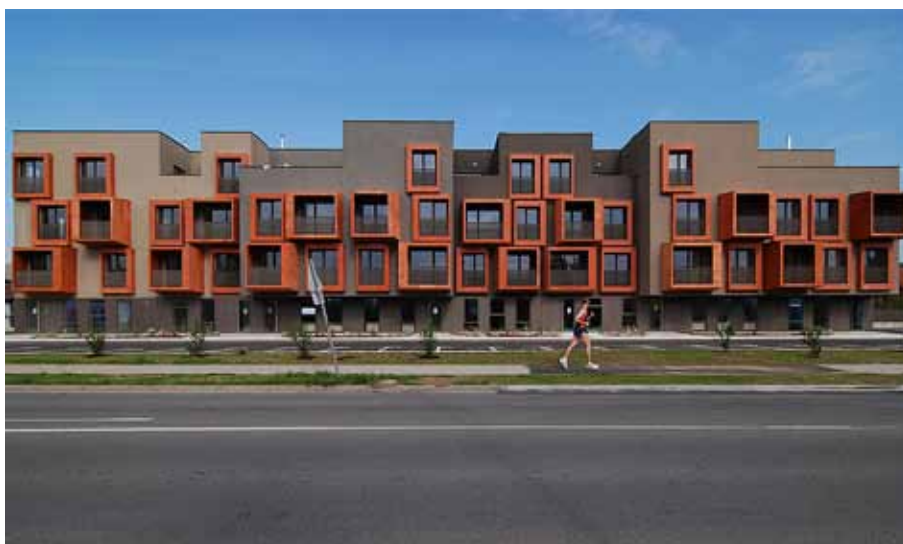
Jižní průčelí s komerčními prostory v přízemí obrácenými do rušné silnice
