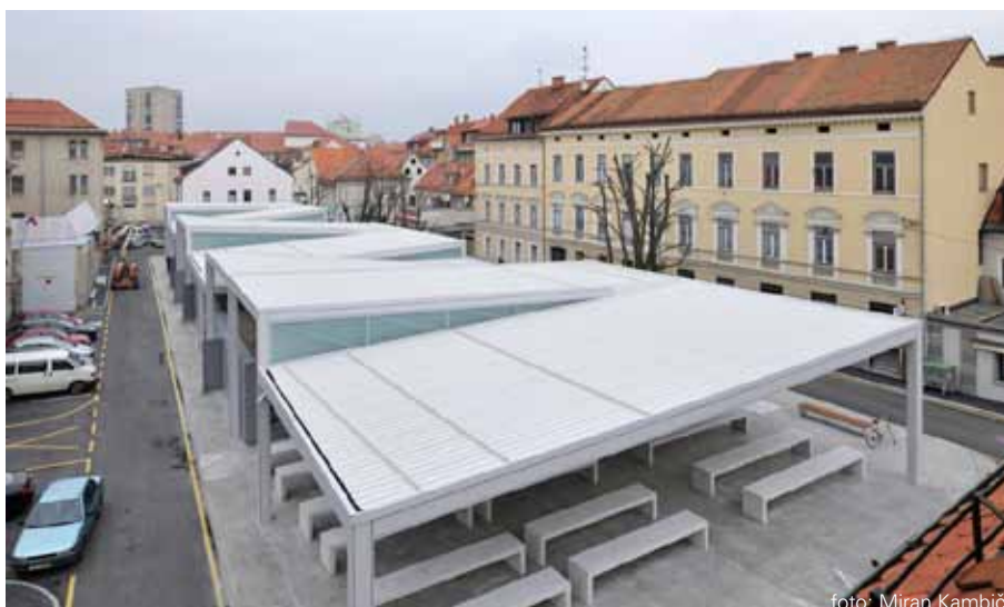
Pohled shora na rozehranané střechy městské tržnice
