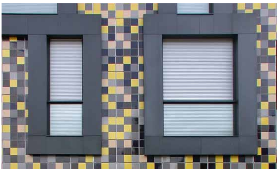
Detail kachličkové 'mločí' fasády
