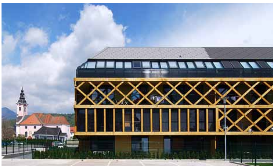
Malebná kompozice bytového domu a kostela pořízená z parkoviště supermarketu
