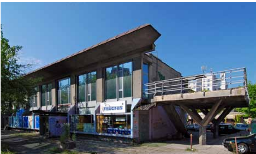
Na severním konci nákupního centra se nachází balkon s betonovými skulpturálními podpěrami
