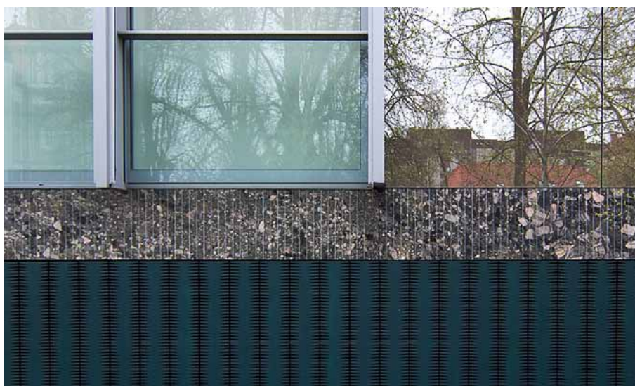
Detail fasády kombinující zrcadlové sklo, frézovaný kámen a profilovaný plech
