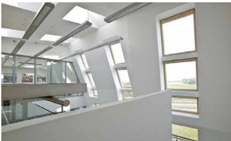
Vícepodlažní administrativní část s velkými prosklenými plochami stěn i střechy
