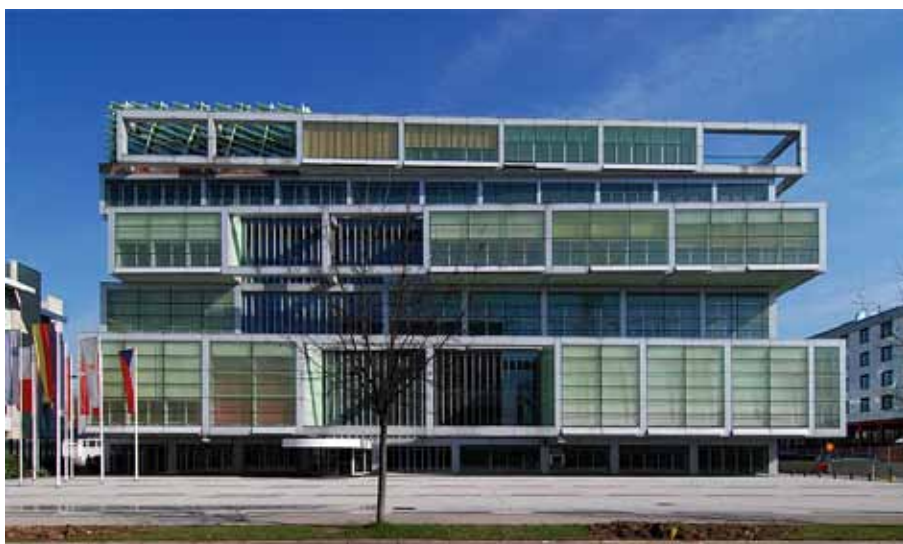
Pohled na hlavní fasádu obrácenou do náměstí
