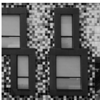
Sadar Vuga Arhitekti: Condominium Trnovski Pristan, Lublaň 2004
