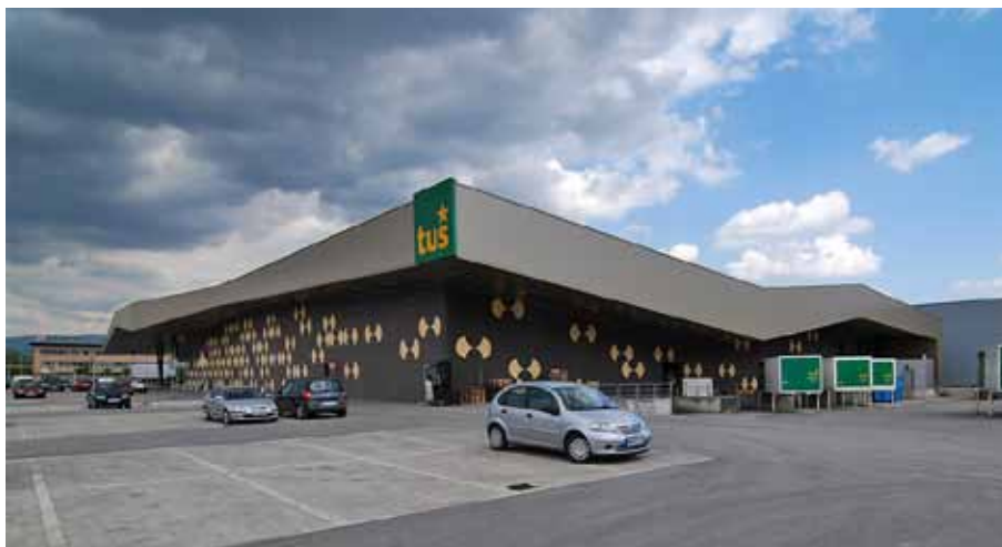
Pohled ze zásobovací zóny supermarketu na zvlněnou střechu
