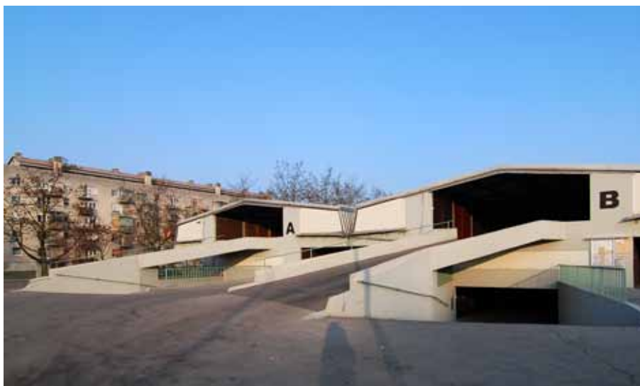
Trojice parkovacích domů Triplex A na poválečném sídlišti Bežigrad na severu Lublaně
