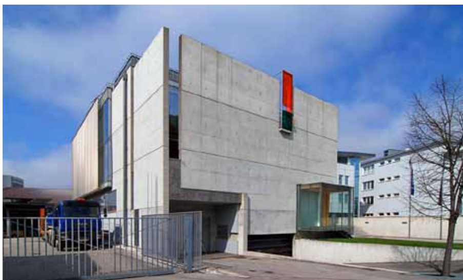
Betonový plášť se před svým okolím neuzavírá, panely nepřiléhají a umožňují vzájemný kontakt
