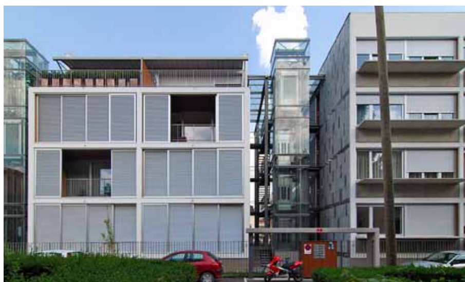
Jeden ze segmentů bytového domu s proskleným komunikačním jádrem
