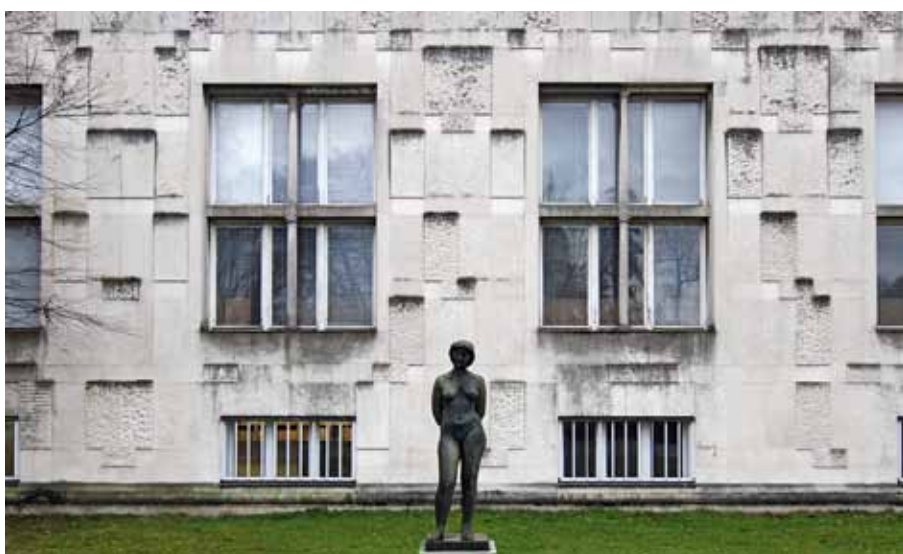
Detail kamenné fasády
