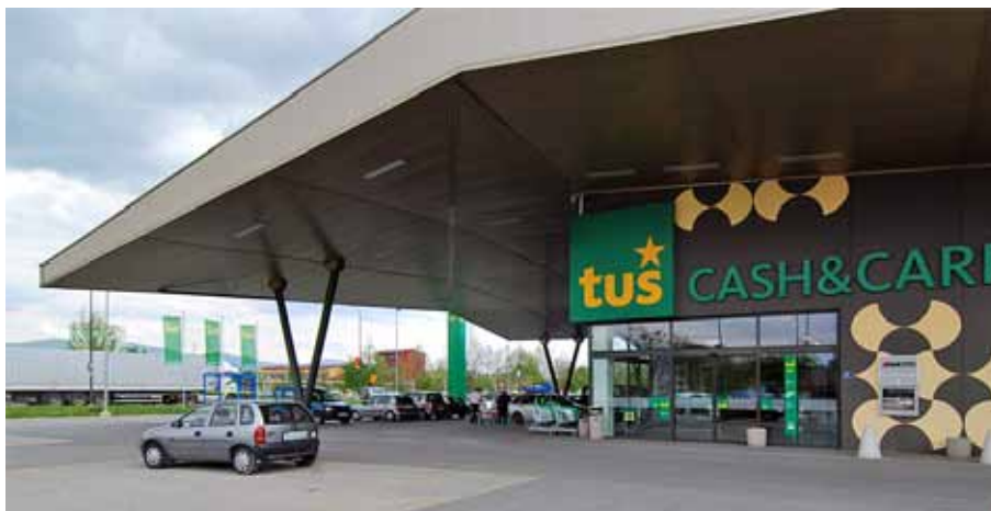
Vstupní část do supermarketu s přečnívající střechou
