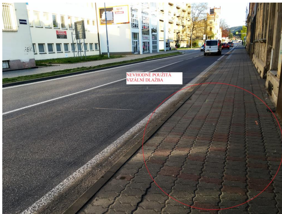
Obrázek 37 Vizuálně kontrastní dlažba použita pro doplnění ostatních dlažebních kostek
