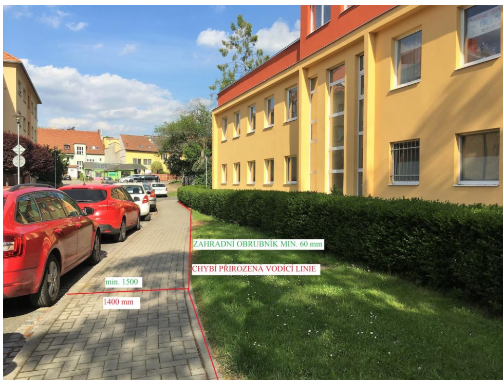
Obrázek 31 Přístupová komunikace k objektu SONS
