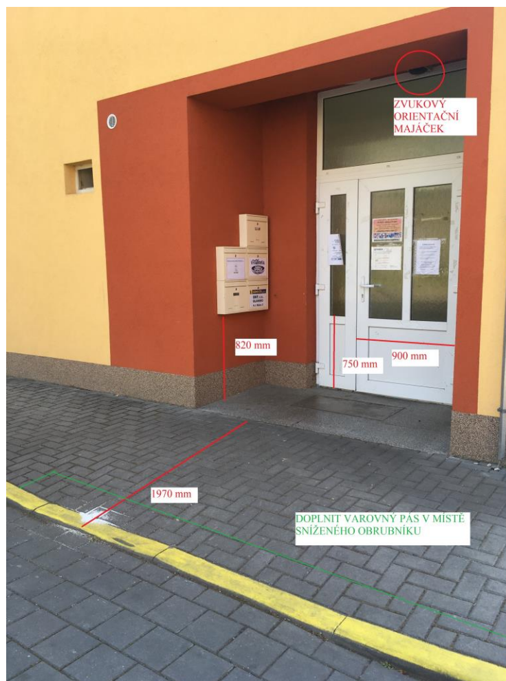
Obrázek 30 Hlavní vstup do budovy SONS
