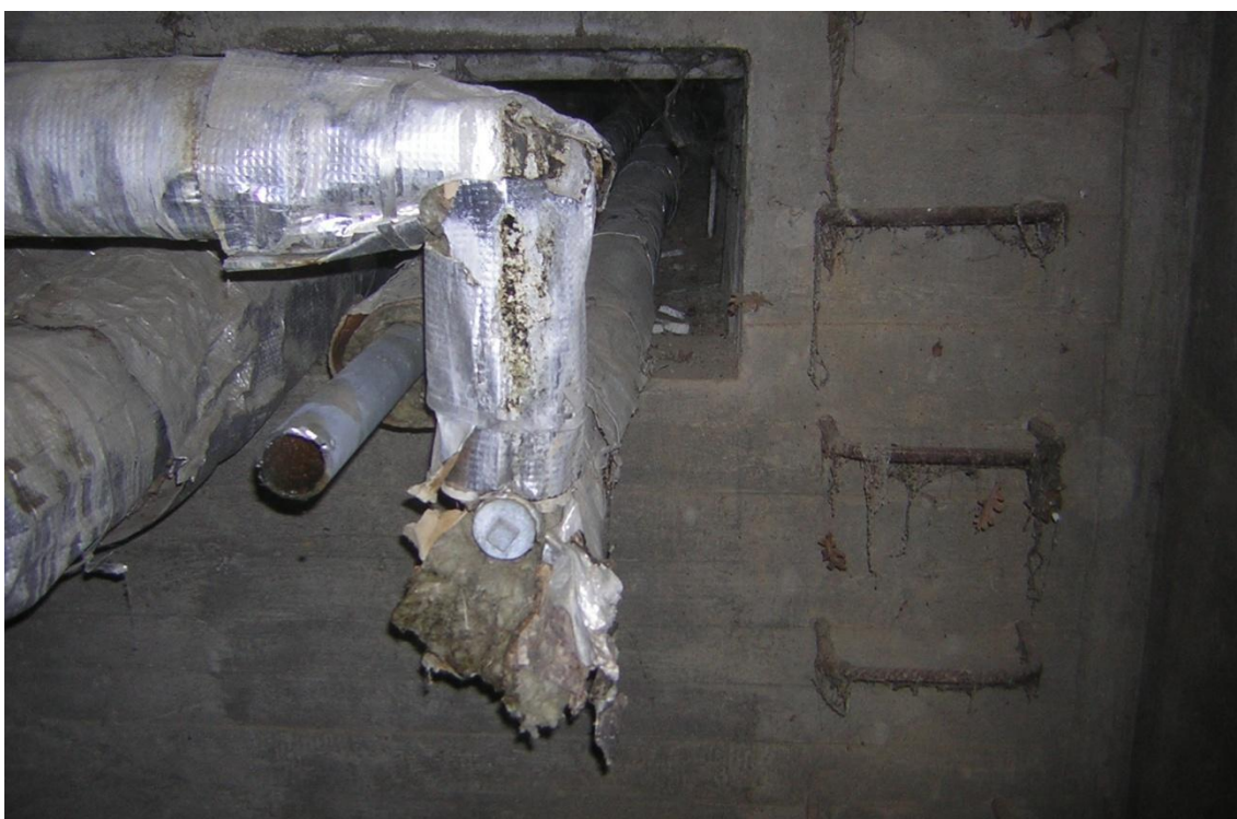
Snímek č. 3: Vedení potrubí po odříznutí
