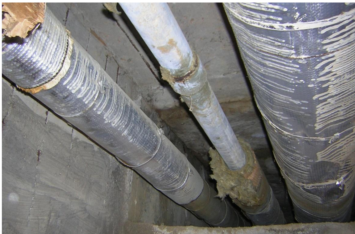
Snímek č. 2: Vedení potrubí před odříznutím
