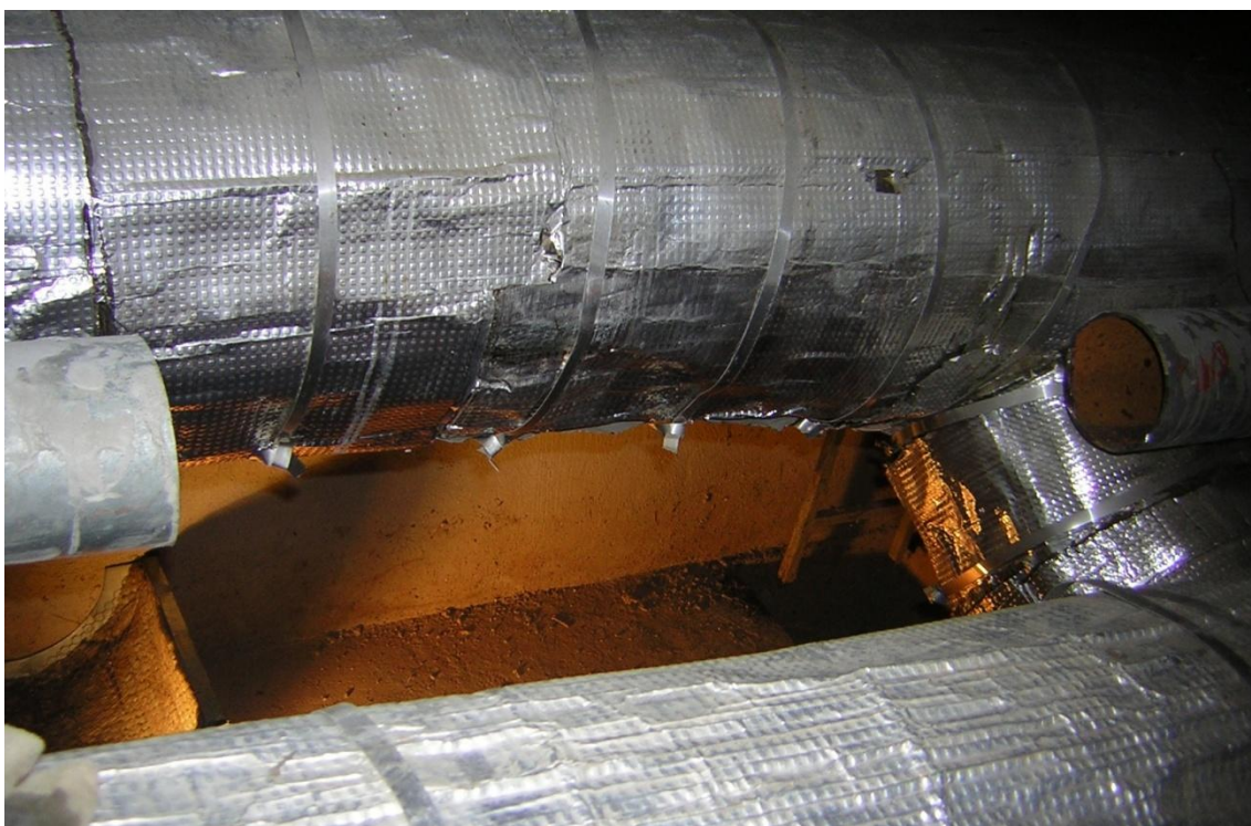
Snímek č. 4: Vedení potrubí po odříznutí
