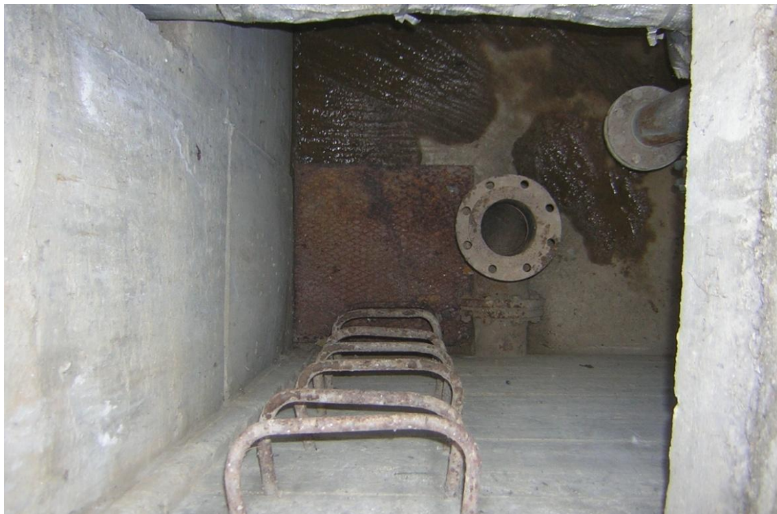
Snímek č. 1: Příprava šachty - sestup
