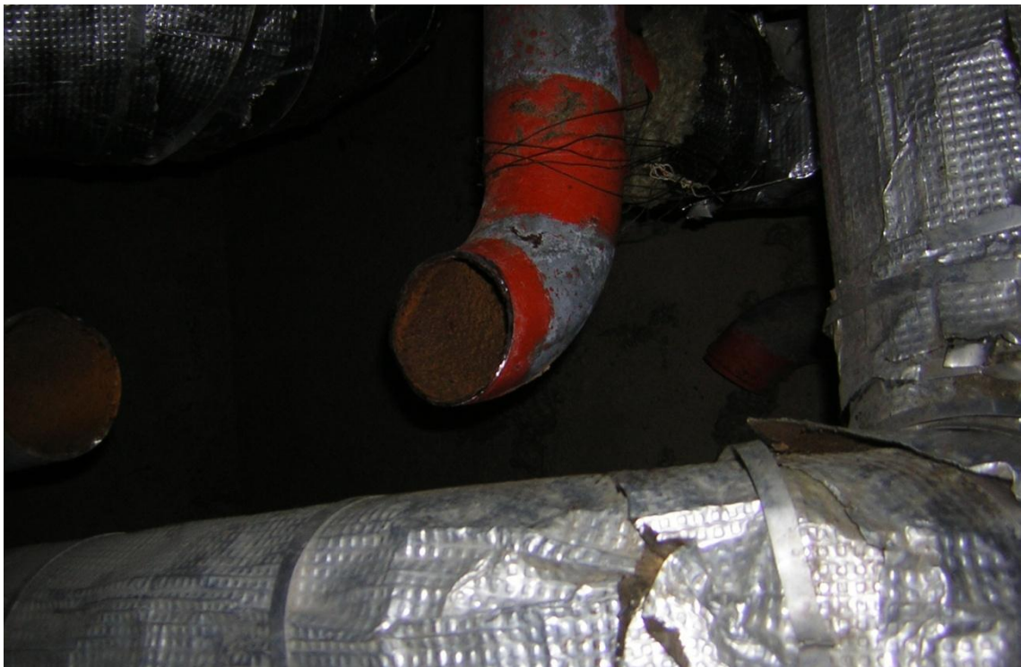
Snímek č. 5: Vedení potrubí po odříznutí
