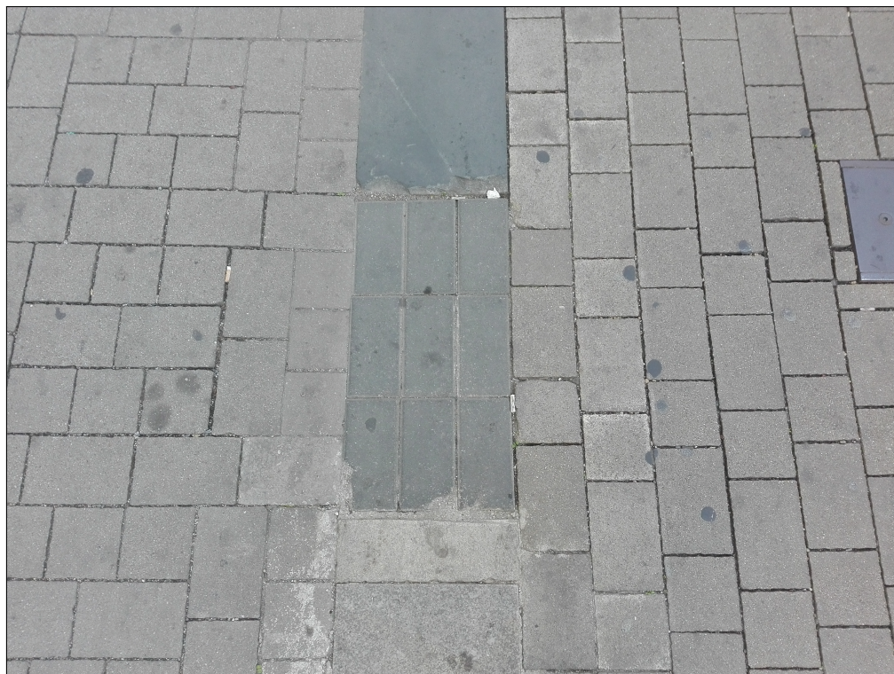
Obrázek 5.6: Optické oddělení tramvajové trati
