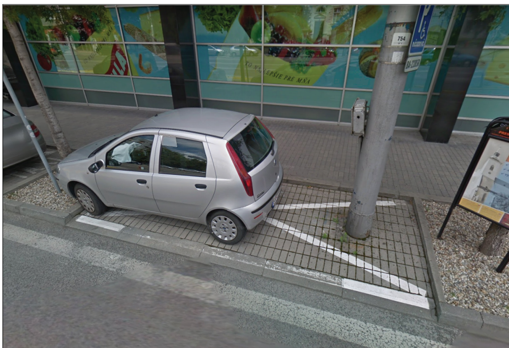
Obrázek 5.3: Nevhodné provedení vyhrazeného stání
