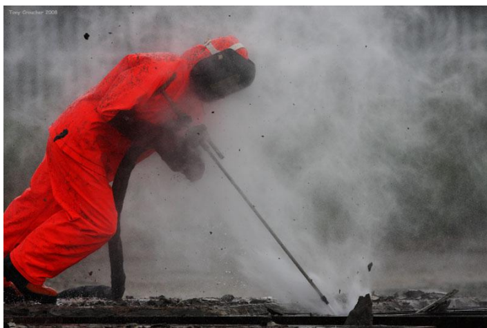
Obr. 2.2 Obnažování betonu metodou AWJ.[24]
