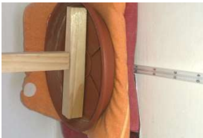
Obr. č. 31- Měření povrchové teploty stěny. [Archiv autora DP]
