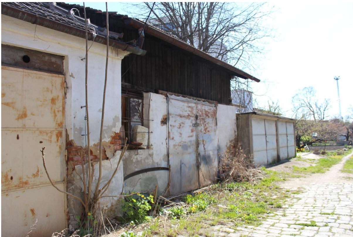
Obr. č. 19 - Autoopravna
