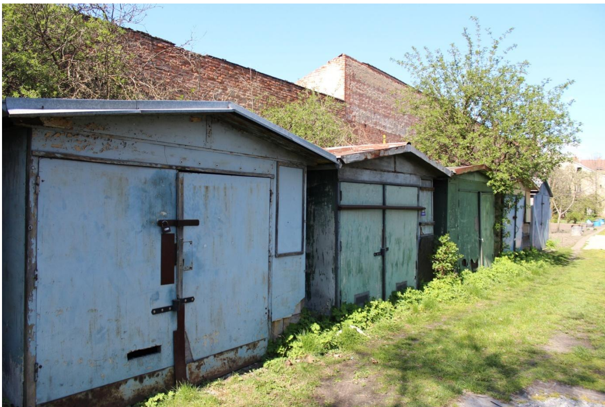
Obr. č. 22 - Soubor staveb garáží v pravé zadní části území
