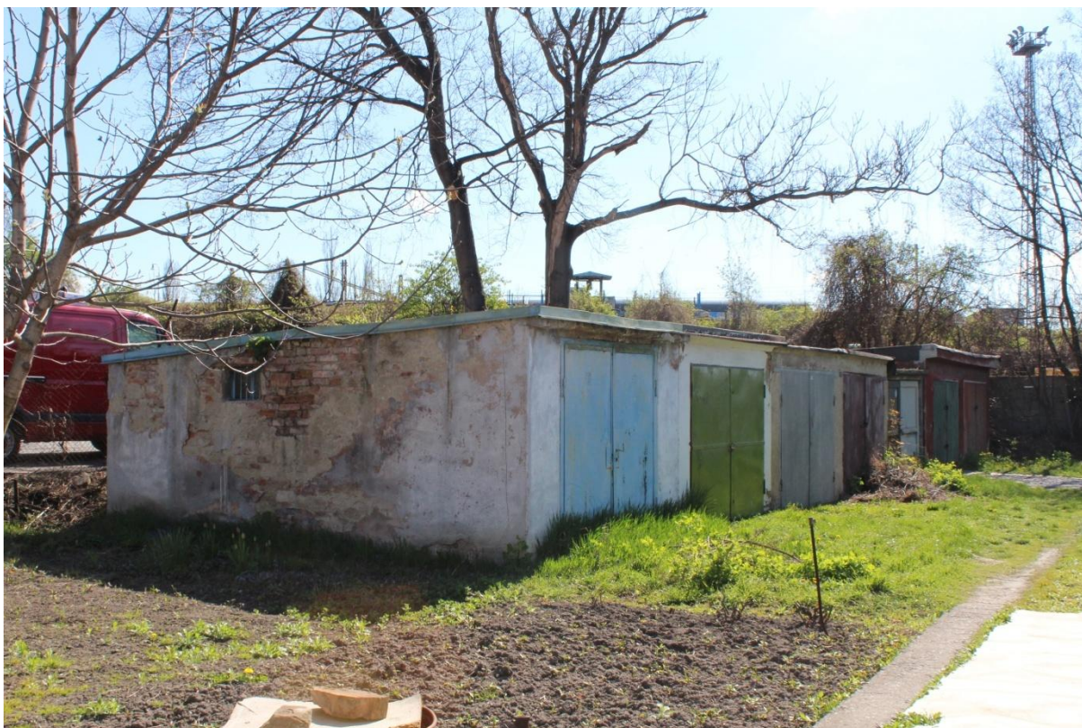
Obr. č. 21 - Soubor staveb garáží v levé zadní části území
