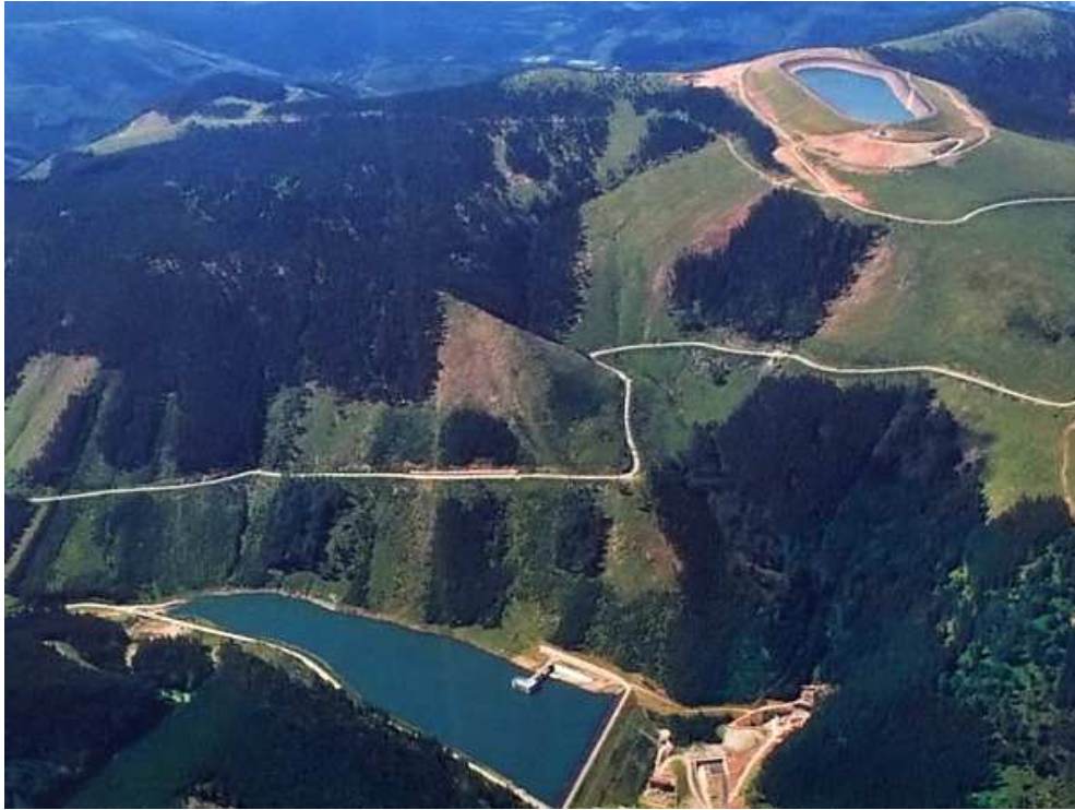
Obrázek 3: Přečerpávací vodní elektrárna Dlouhé Stráně
