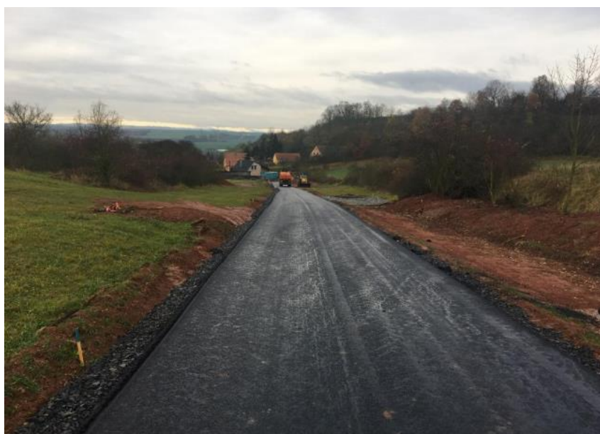
Obrázek 21: Fotografie po pokládce zkušební úseku [3]
