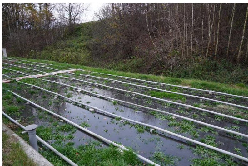
Obr. 10 Tvorba hladiny na povrchu 2. stupně francouzského filtru způsobená kolmatací
