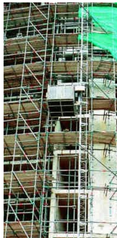
Obr. 1. 1. Nákladní výtah AT (14)
