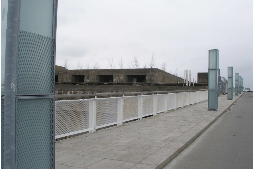
Fotografie - rampa vedoucí na ponorkovou základnu
