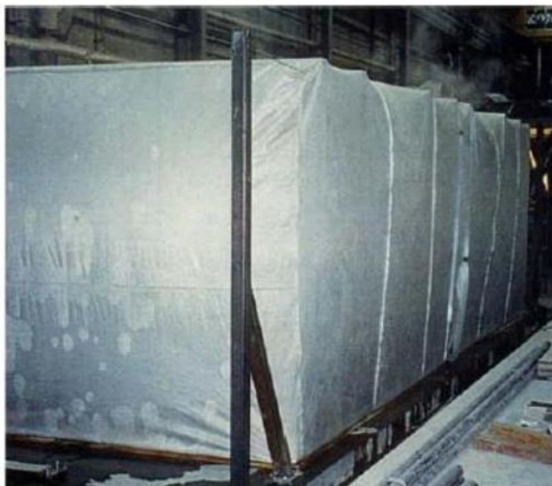
Obrázek 5 Propařování betonu pod folií
