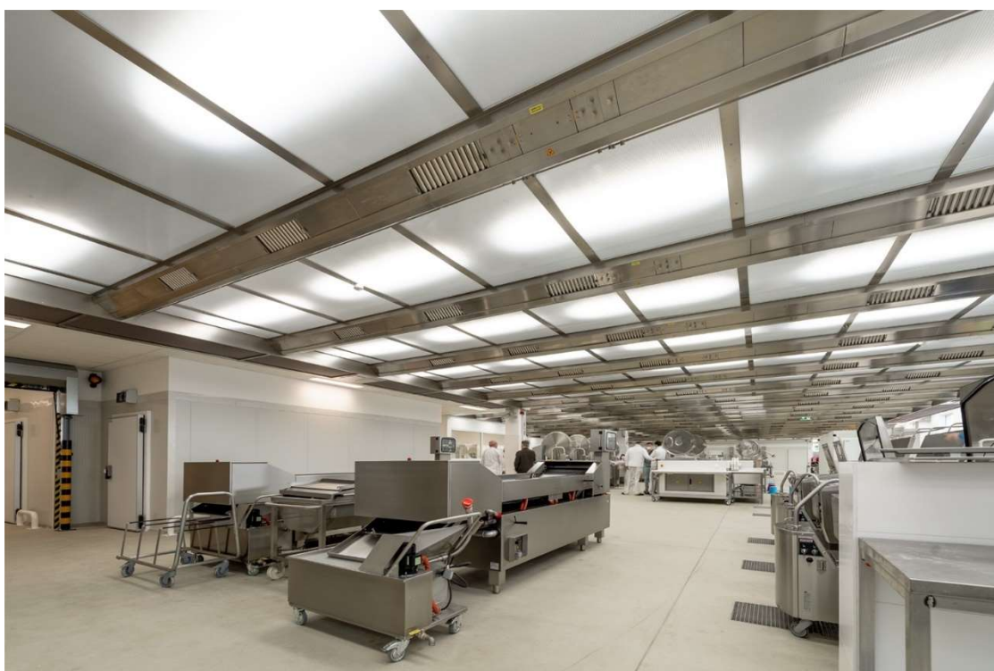
Obr. 13 – ukázka větracího stropu v praxi [12]
