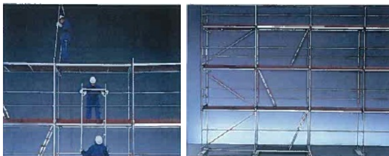
Obr. 73: Montáž polí do výšky
