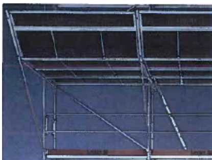
Obr. 71: Montáž stříšky
