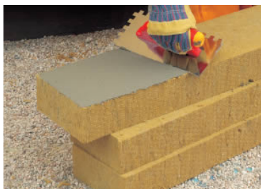
Obr. 77: Nanášení lepící hmoty na minerální desky
