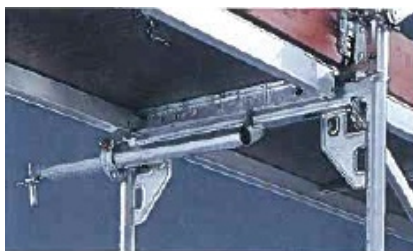
Obr. 74: Montáž kotvení
