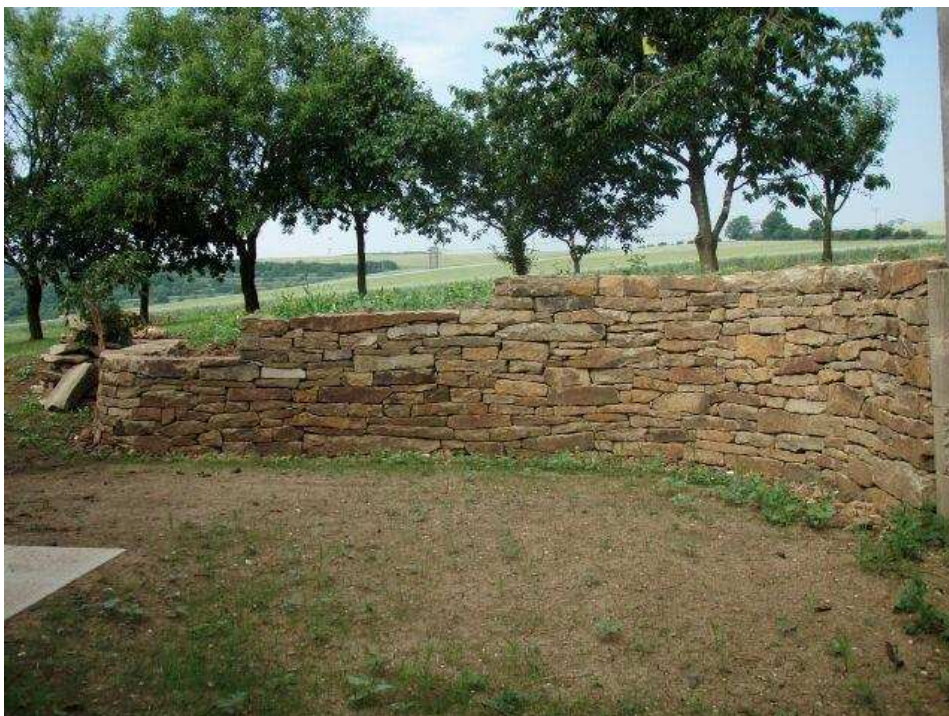
Obr. 2-6 Suchá opěrná zeď – droba Luleč [3]
