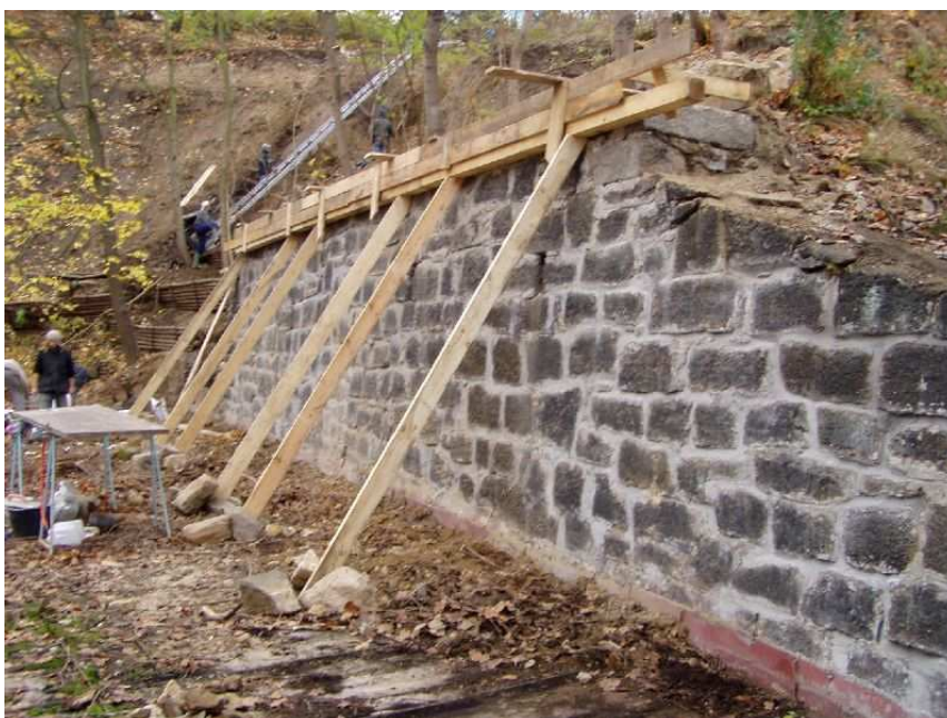
Obr. 2-7 Ukázka kamenné zdi zděné na cementovou maltu [4]
