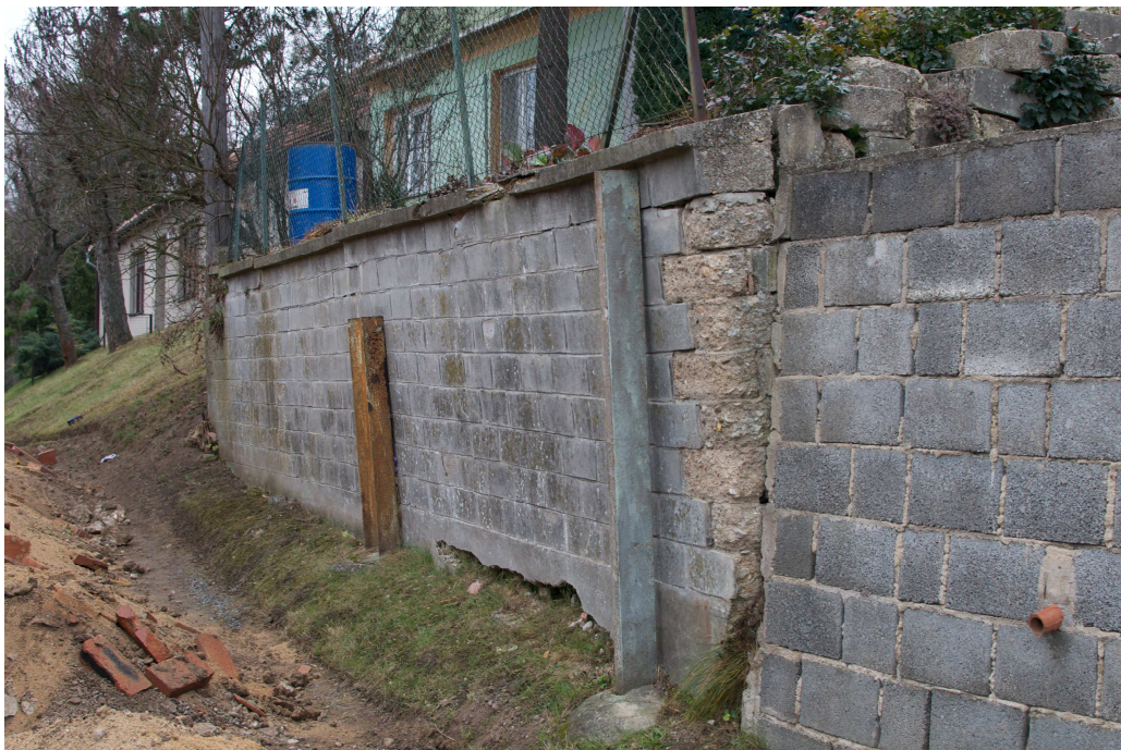
Obr. 6-1 Stávající stav konstrukce
