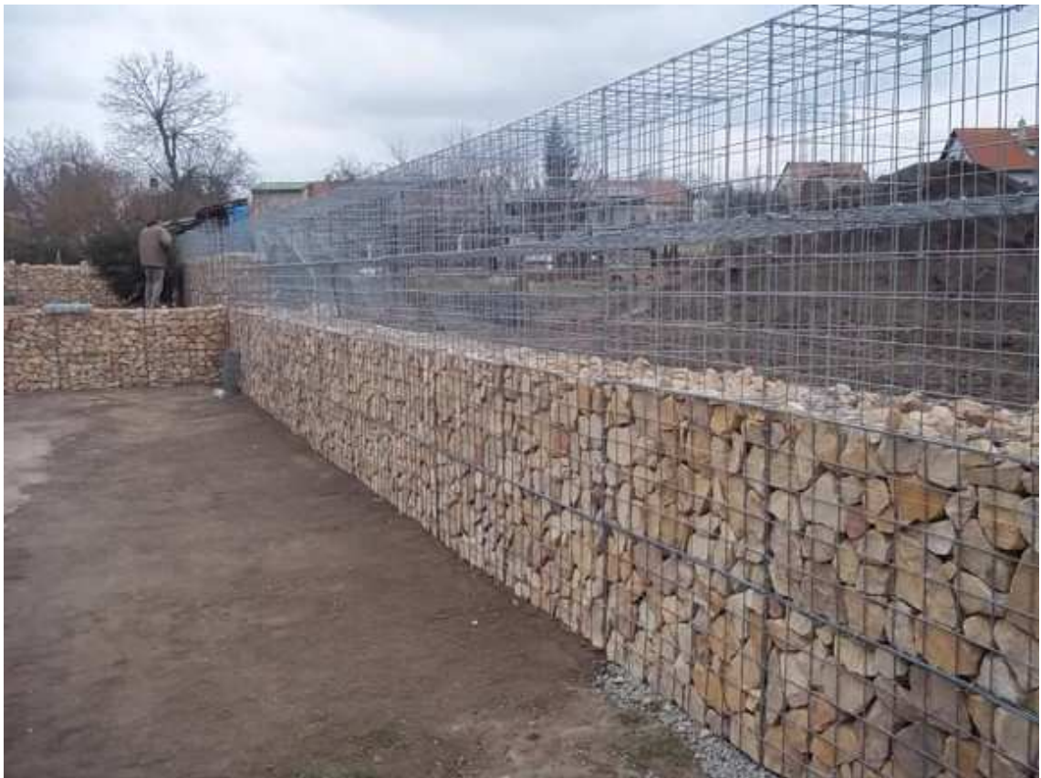
Obr. 3-3 Příklad gabionové stěny [11]
