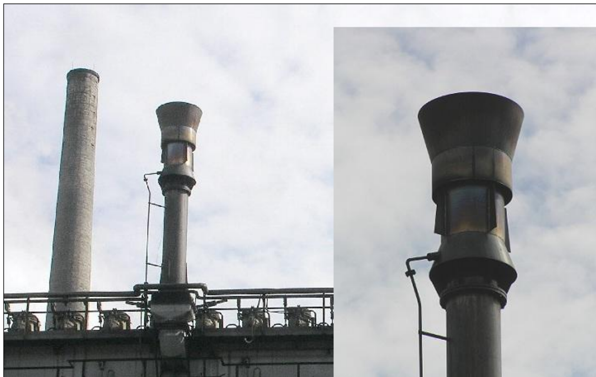
Obr. 3-1 Ukázka a detail atmosférického hořáku spalující koksárenský plyn z koksárenských baterií. Jedná se o typický příklad hořáku v otevřeném spalovacím prostředí.
