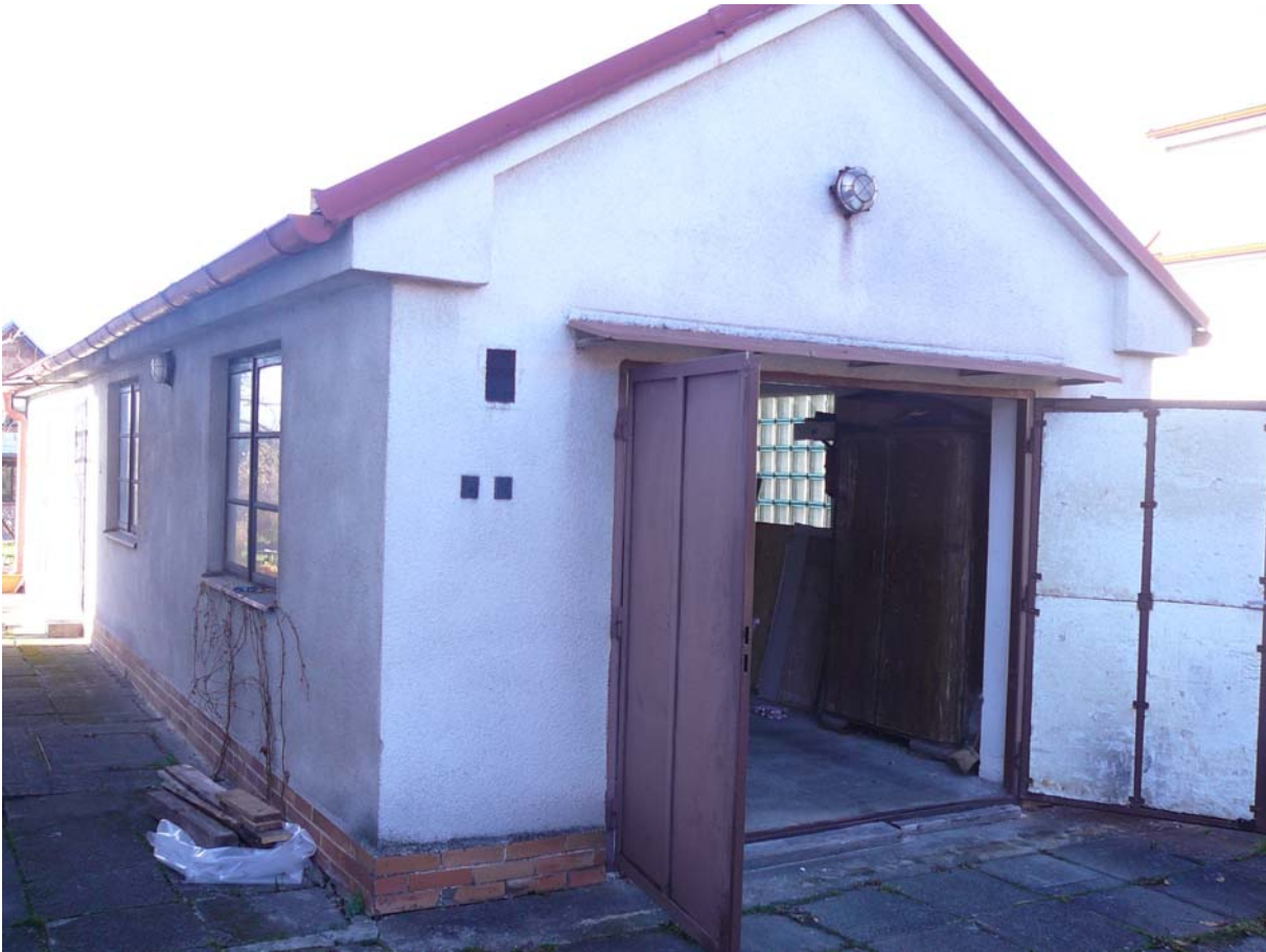
Obr. č. 6 – fotografie garáže č. 1
