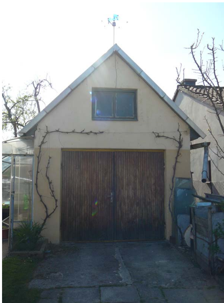
Obr. č. 24 – fotografie garáže č. 8
