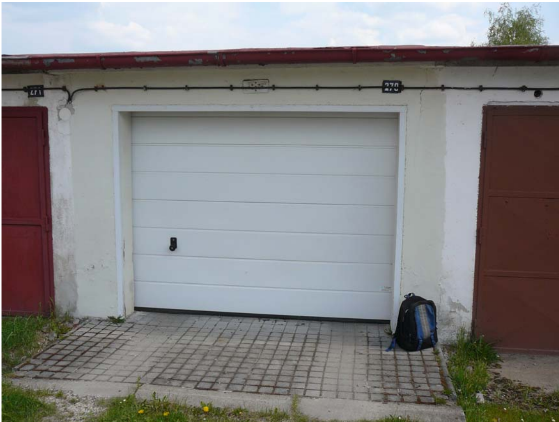
Obr. č. 21 – fotografie garáže č. 7
