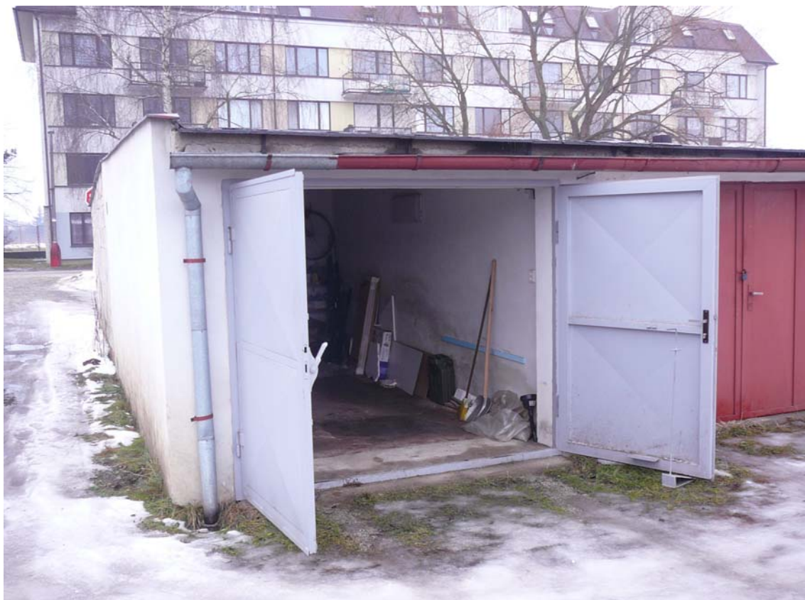
Obr. č. 11 – fotografie garáže č. 3
