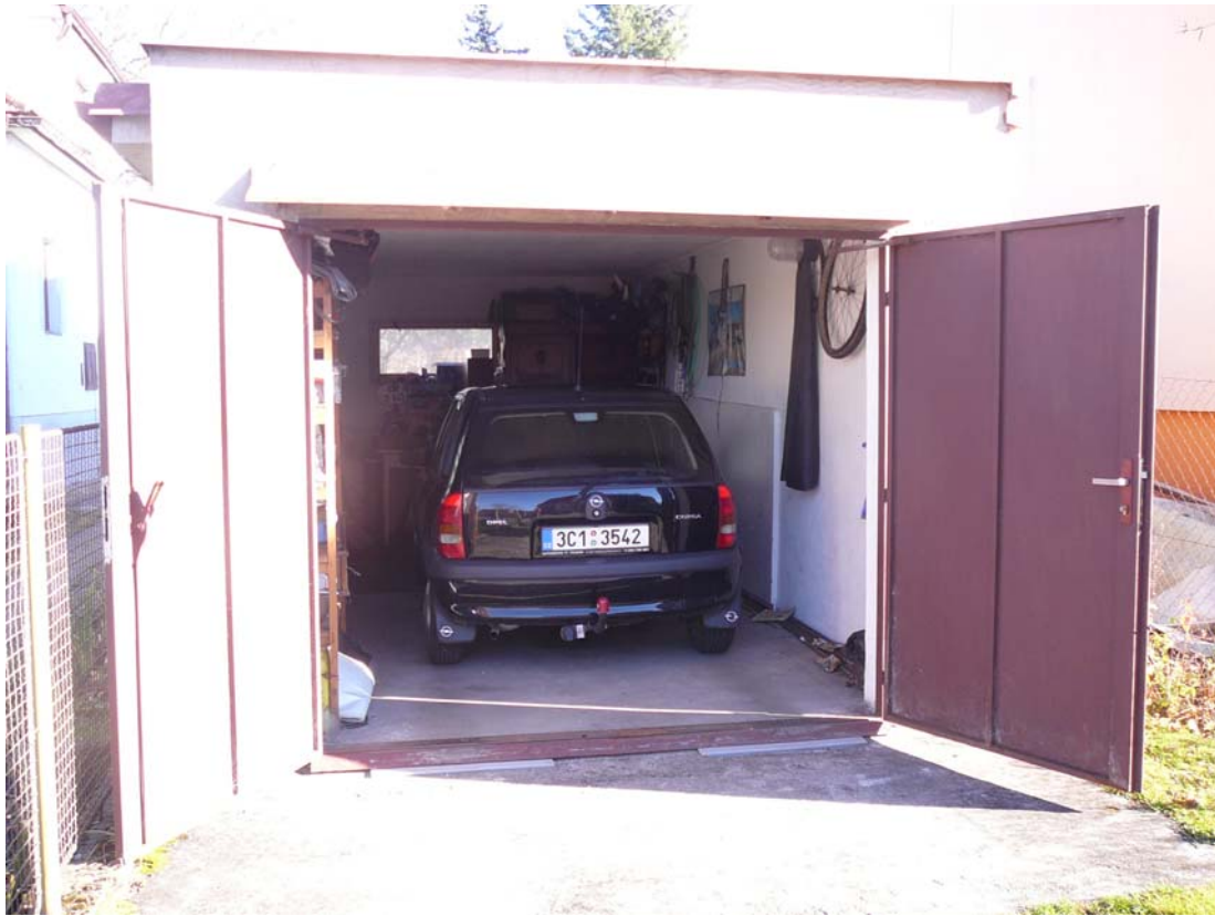
Obr. č. 18 – fotografie garáže č. 6
