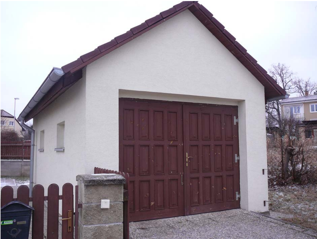
Obr. č. 29 – fotografie garáže č. 10
