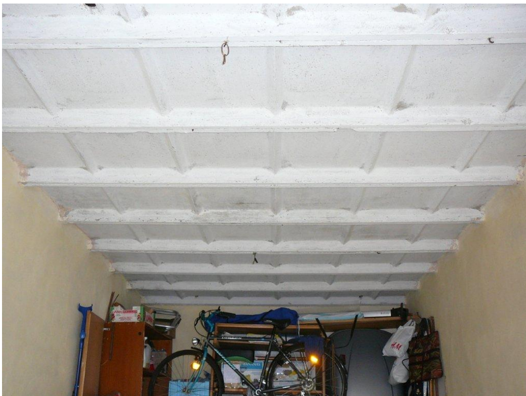
Obr. č. 27 – fotografie na žebrový strop garáže č. 9
