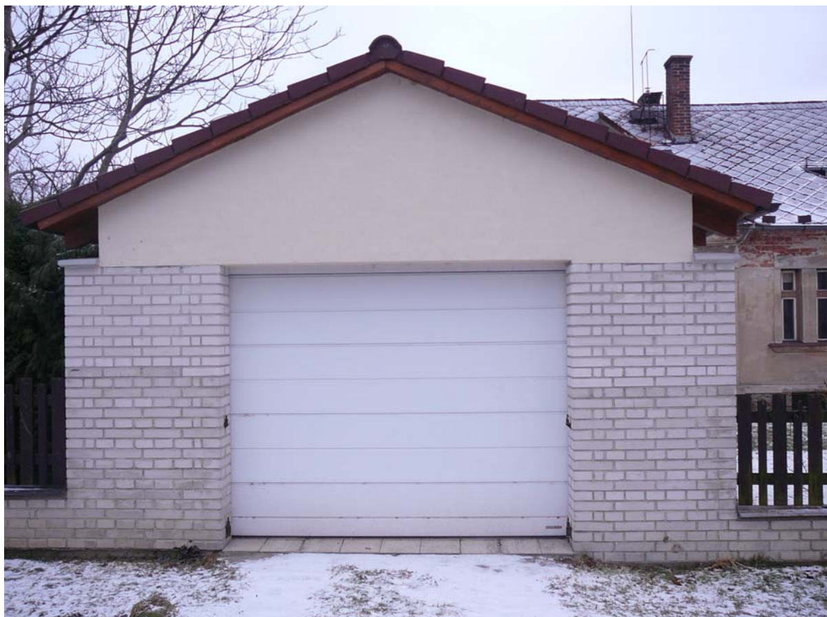
Obr. č. 14 – fotografie garáže č. 4
