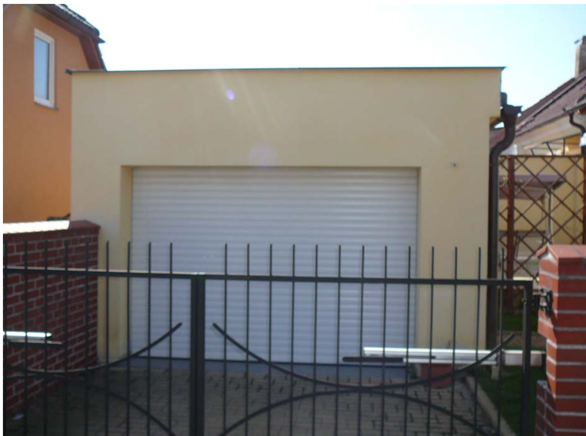
Obr. č. 16 – fotografie garáže č. 5
