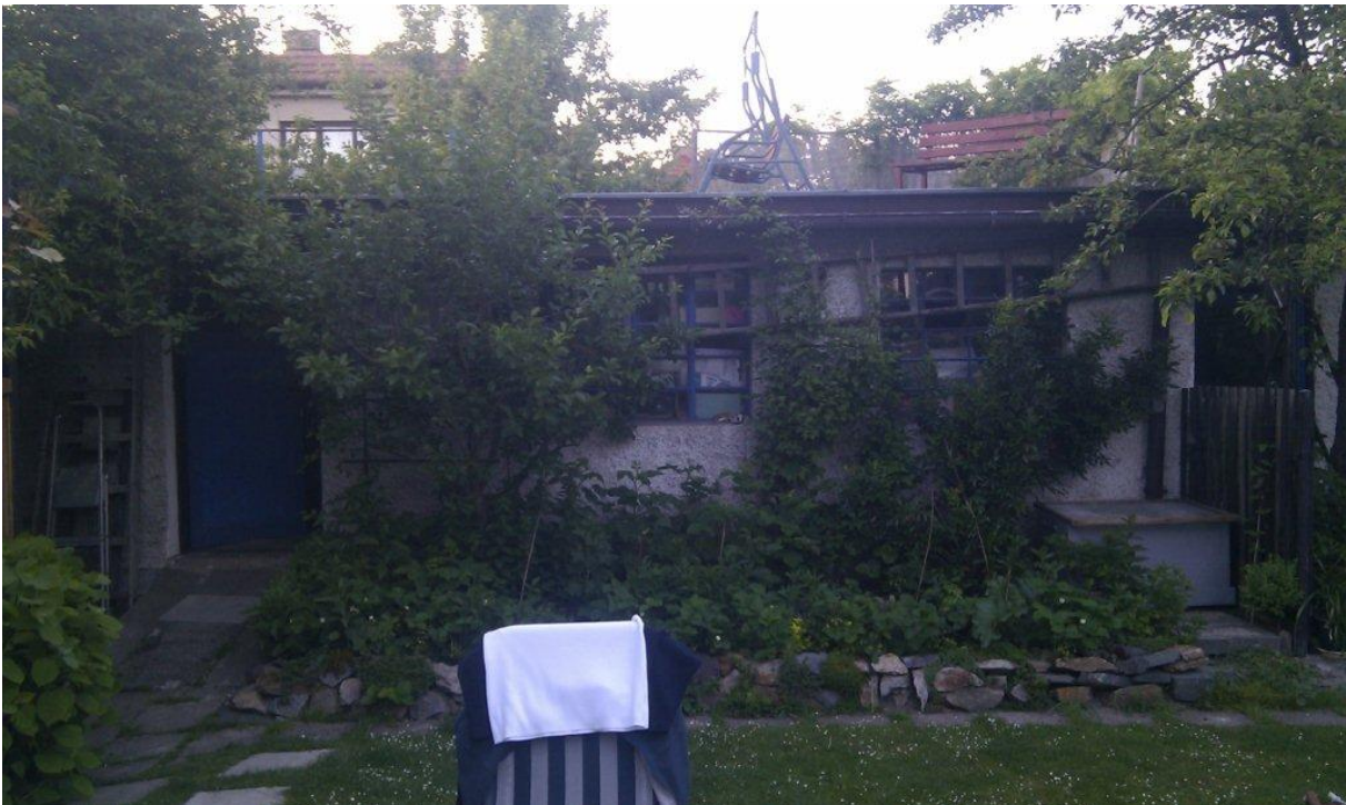
Obr. č. 9 – fotografie garáže č. 1 (pohled z boku)
