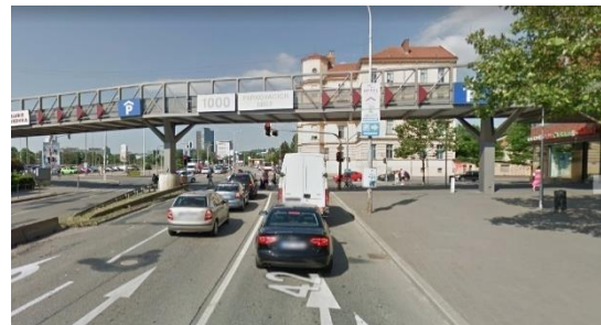
Obrázek 34: Pohled na podjezd na ulici Zvonařka
