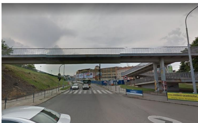
Obrázek 17: Pohled na podjezd pod komunikací pro pěší
