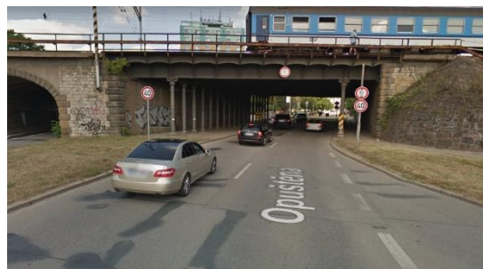
Obrázek 35: Pohled na podjezd na ulici Opuštěná
