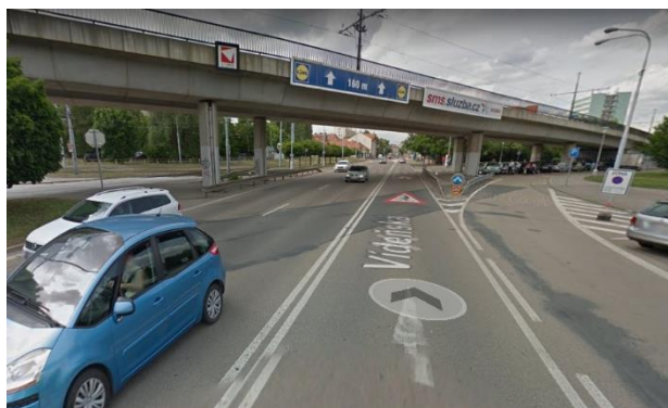
Obrázek 9: Pohled na podjezd pod železniční tratí
