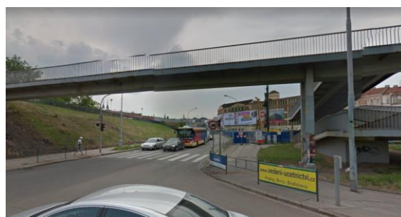
Obrázek 27: Pohled na podjezd na ulici Plotní
