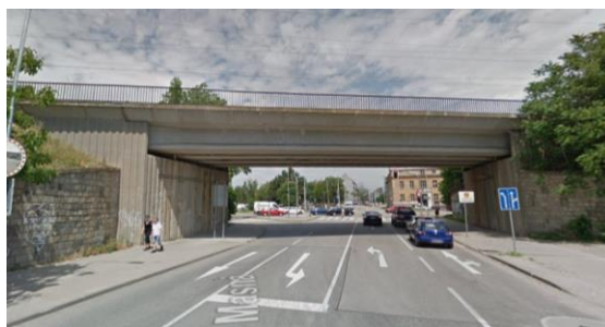
Obrázek 25: Pohled na podjezd na ulici Mastná
