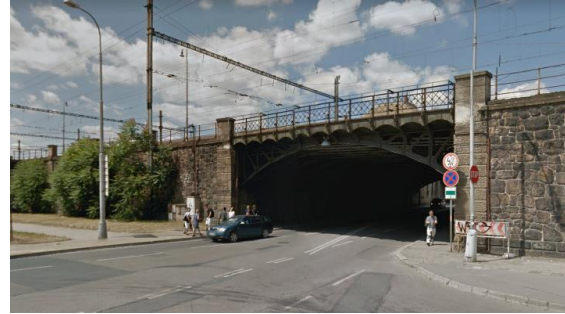
Obrázek 31: Pohled na podjezd na ulici Úzká
