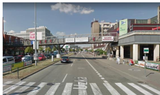
Obrázek 29: Pohled na podjezd na ulici Úzká
