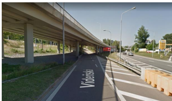
Obrázek 8: Pohled na podjezd pod komunikací Heršpická
