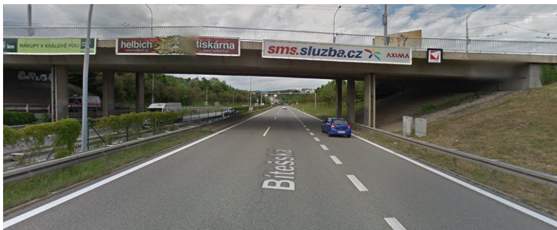
Obrázek 108: Pohled na podjezd pod mostem
