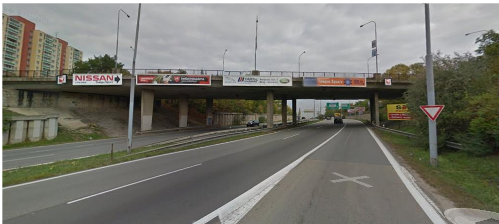
Obrázek 106: Podjezd pod mostem
