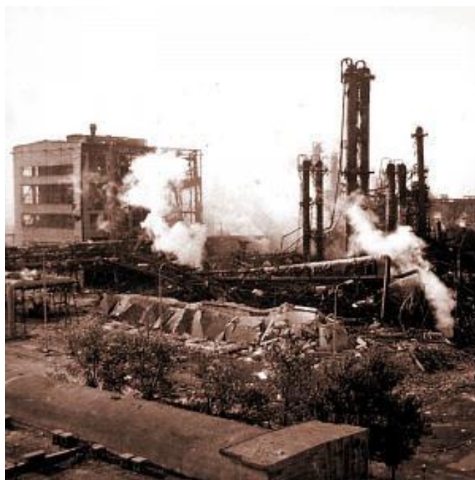
Obr. č. 4: Havária v Záluží u Mostu
