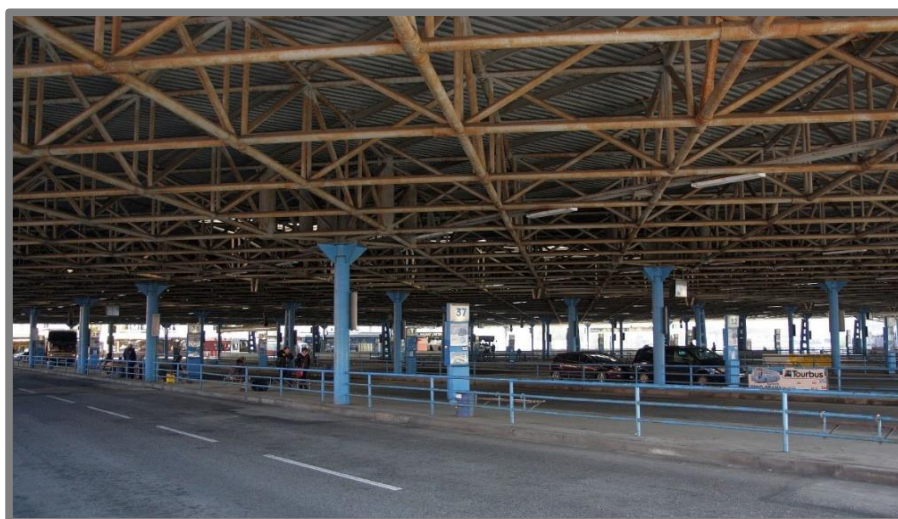
Obr. 4.9: ÚAN Brno Zvonařka – pohled na konstrukci [9]
