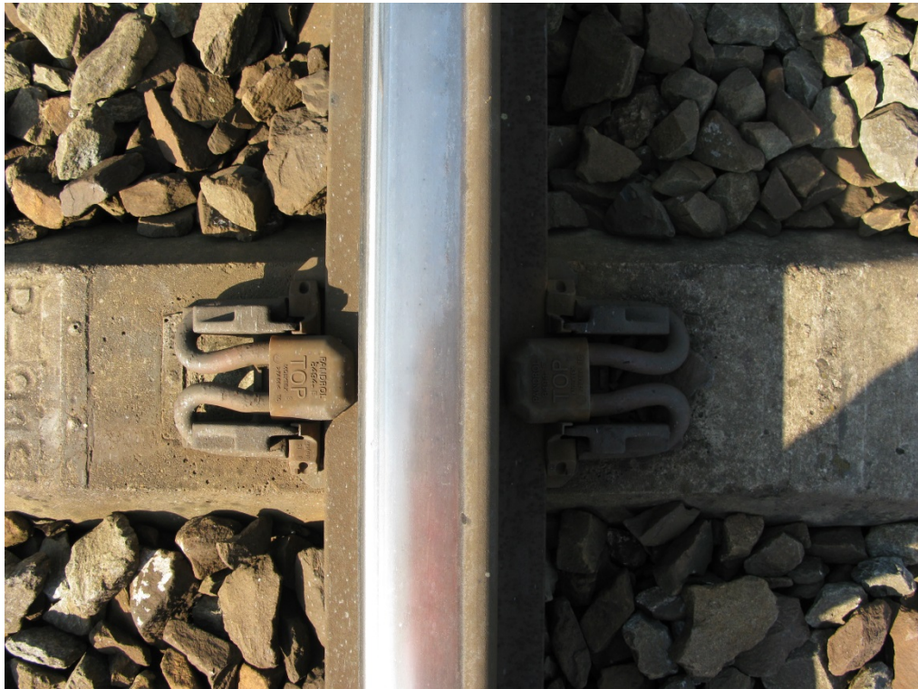
Obr. A. 2 Upevnění Pandrol FCI
