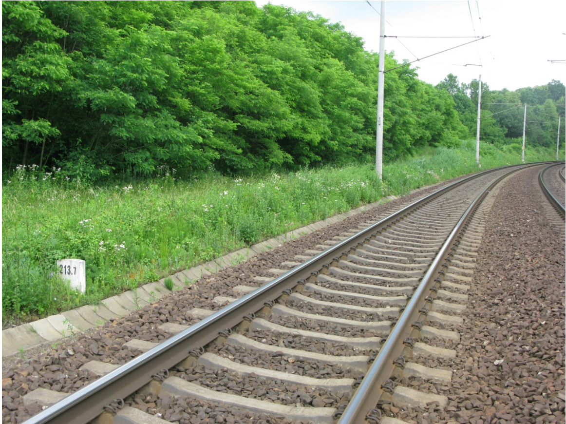
Obr. 5. 1 Měřicí úsek Hranice na Moravě km 213,692
