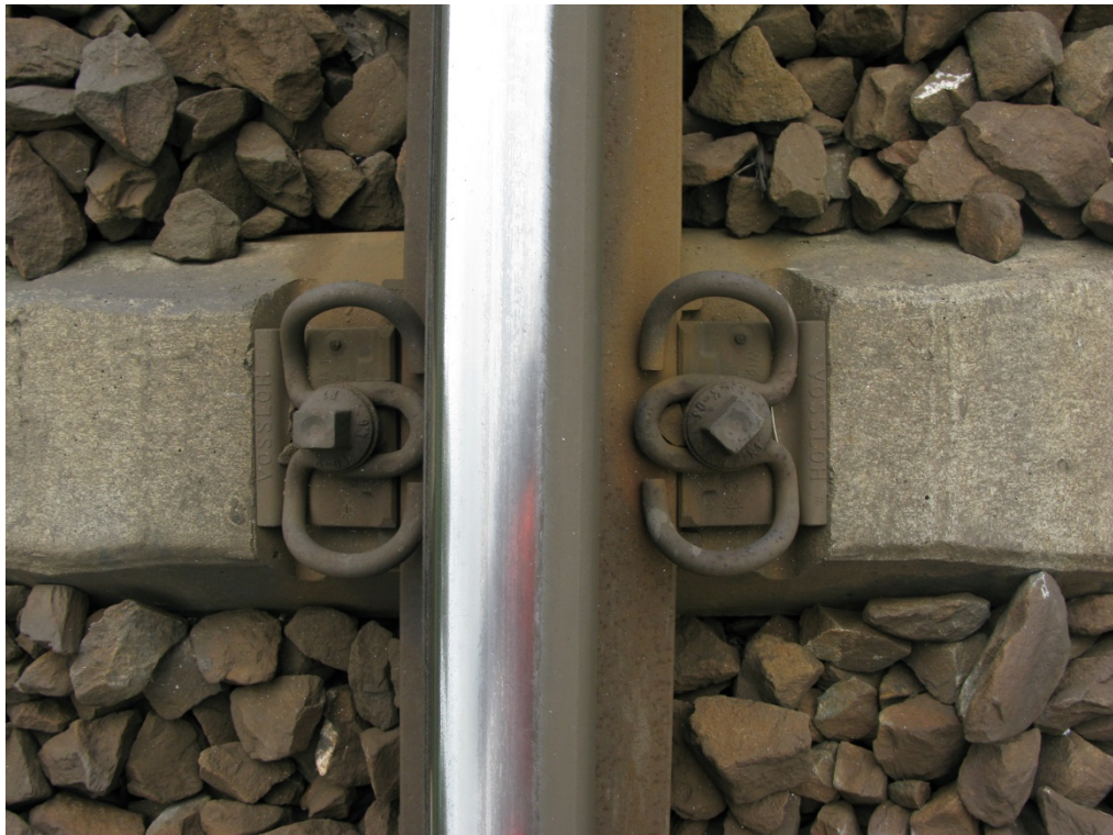
Obr. A. 1 Upevnění Vossloh W14
