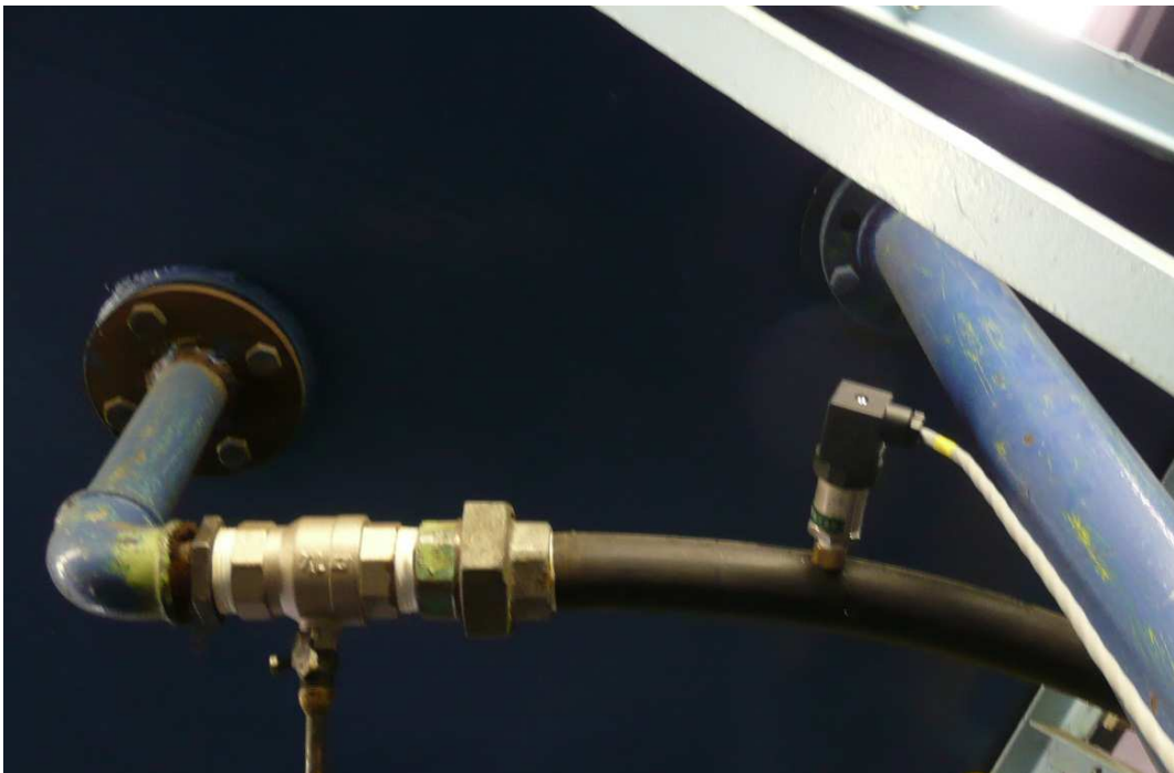
Obrázok 23: Horný guľový uzáver a snímač tlaku
