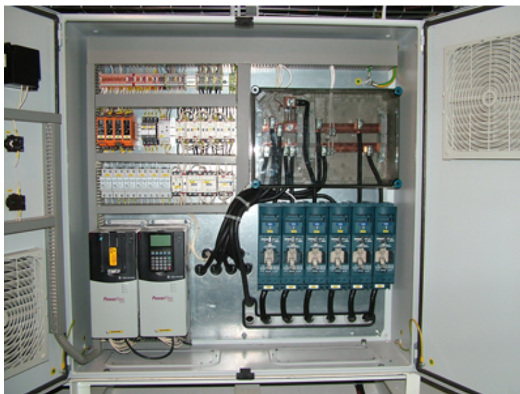
Obr. 1.4: Zjednodušení zapojení přístrojů lodi s použitím AS-i [2]
