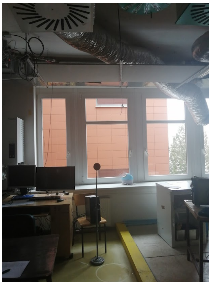
Obrázek D1.2: Instalace stropního panelu
