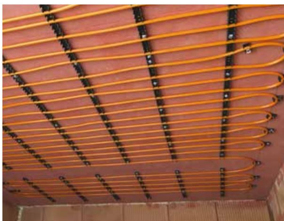
Obrázek A1.1: Otopný had umístěný v omítce [6]
