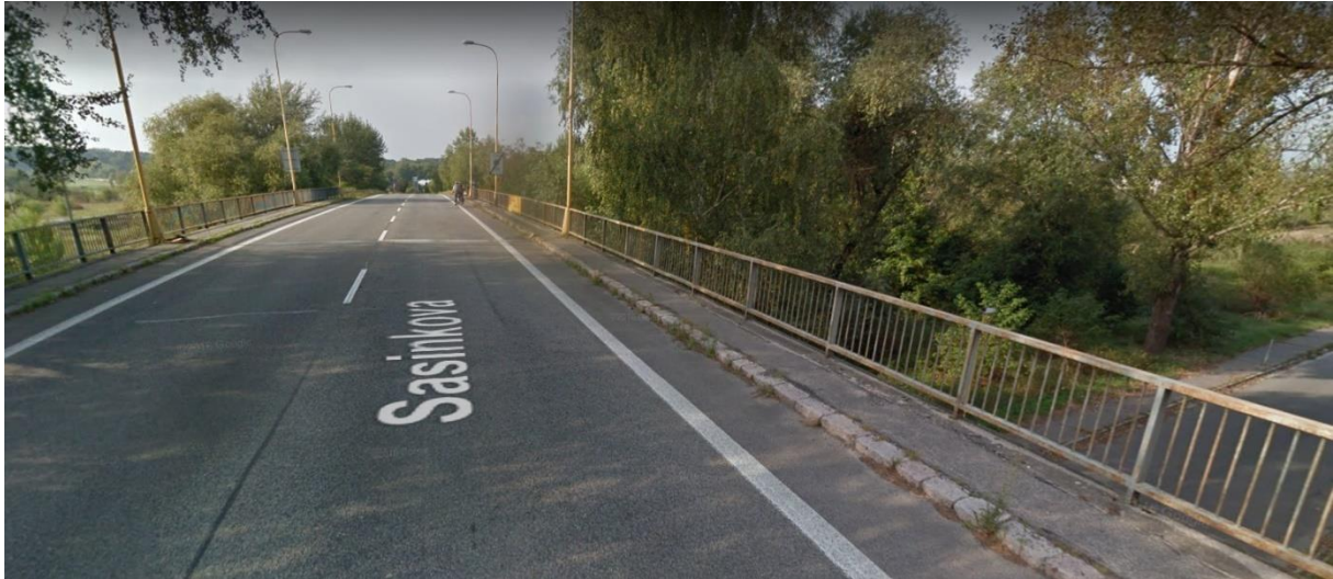
Obr. 5 – Únosnost mostu Sasinkova [1]
