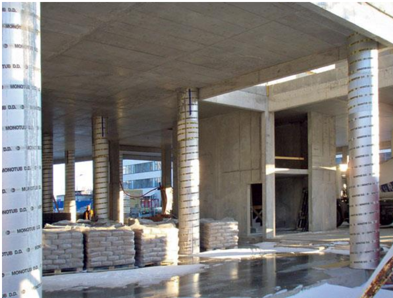
Obr. 3 – Konstrukce před odbedněním [1]
