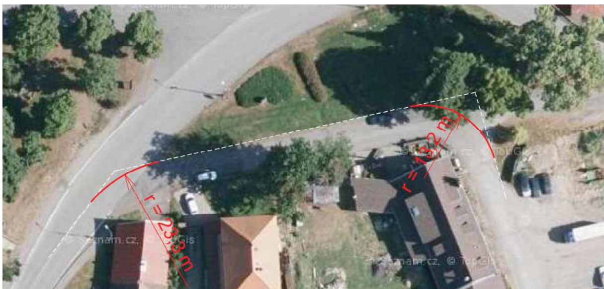
Obrázek C.2.1.1-5: Odbočka na stavenišť – Česká Bělá (zdroj: [7])
