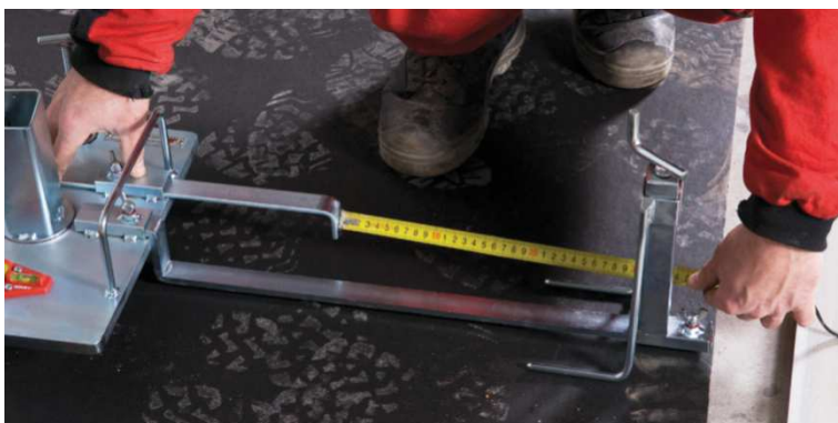
Obrázek E.7.1-2: Nastavení šířky maltového lože (zdroj: [2])
