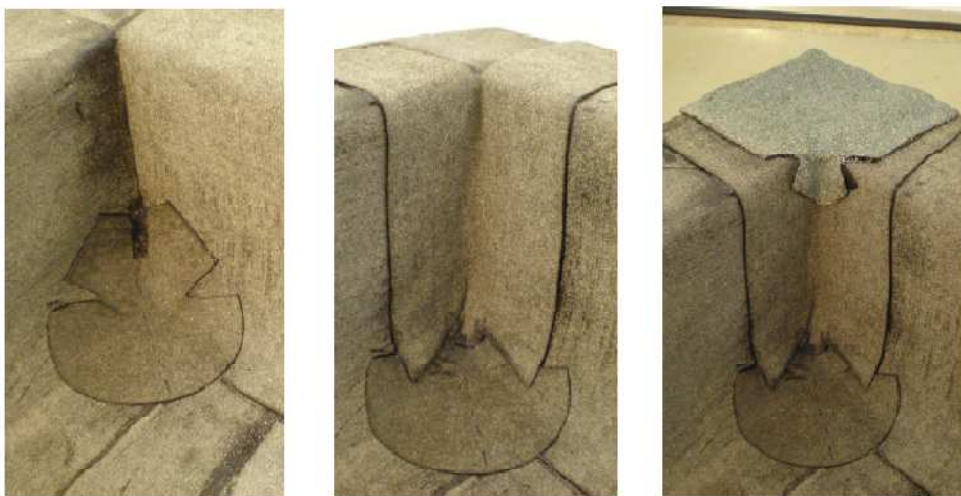
Obrázek D.7.1.5: Natavení univerzální tvarovky a koutové tvarovky (zdroj: [6])
