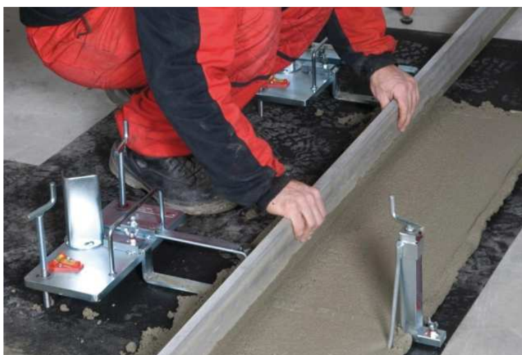
Obrázek E.7.1-3: Srovnání malty hliníkovou lať (zdroj: [2])
