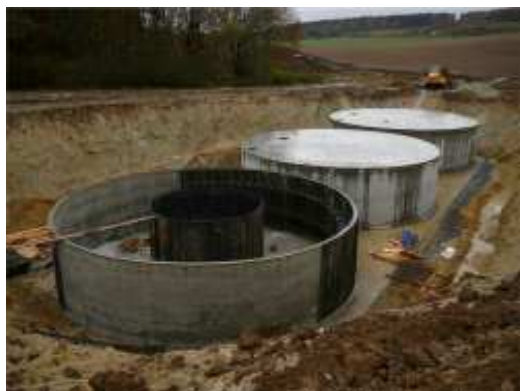
Obrázek 11: Příklad retenční kruhové nádrže u logistického centra v Plzni (16)
