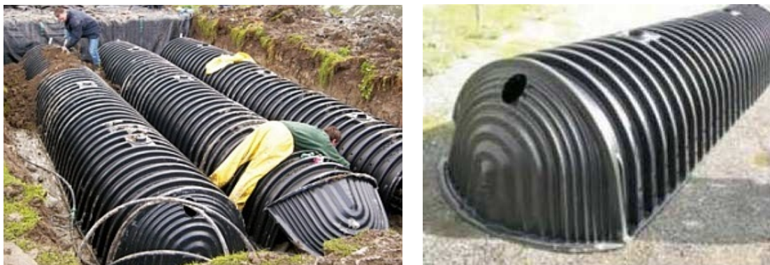
Obrázek 5: Tunelový systém retence a vsakování (13)
