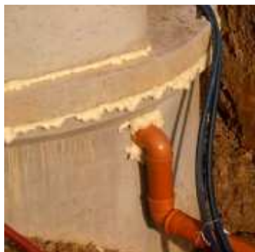
Obrázek 23: Těsnění betonové nádrže (10)
