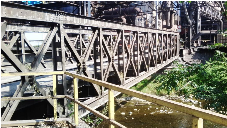
Obr. 5: Fotografie mostu ze strany veřejné komunikace
