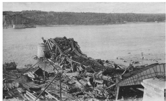
Obr. 2: Kolaps Pont du Québec z roku 1907 [4]
