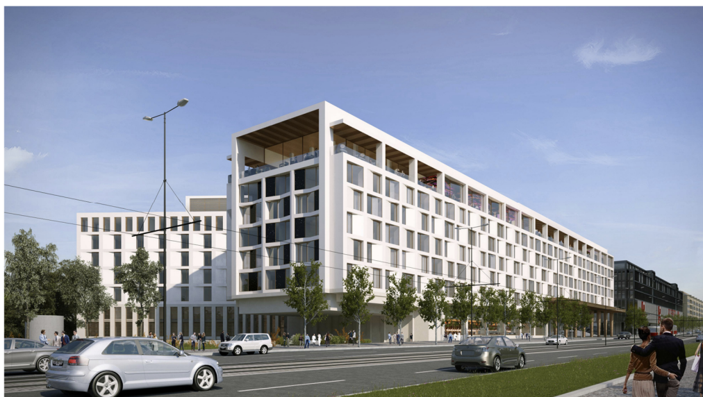
Obrázek 1: Perspektiva na vyšetřovanou část konstrukce [18]
