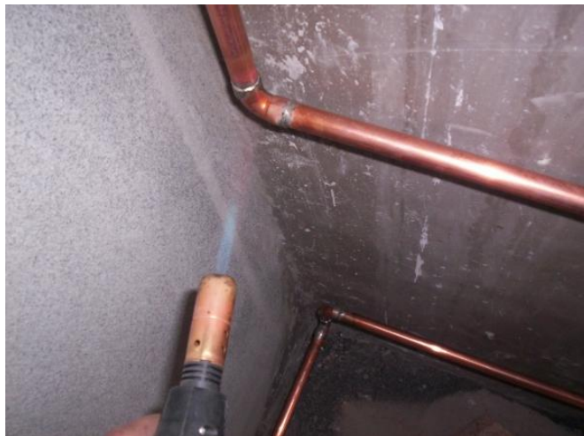
Obr.1-1: Pájení měděného potrubí [4]
