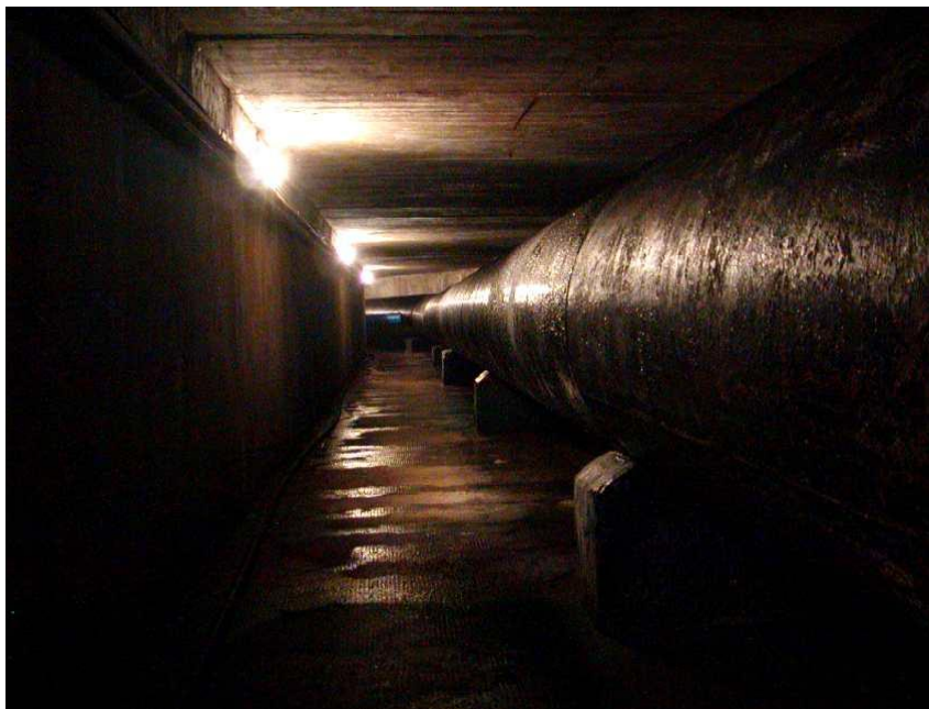
Obr. 4 Štola násosky II. březovského vodovodu [7]
