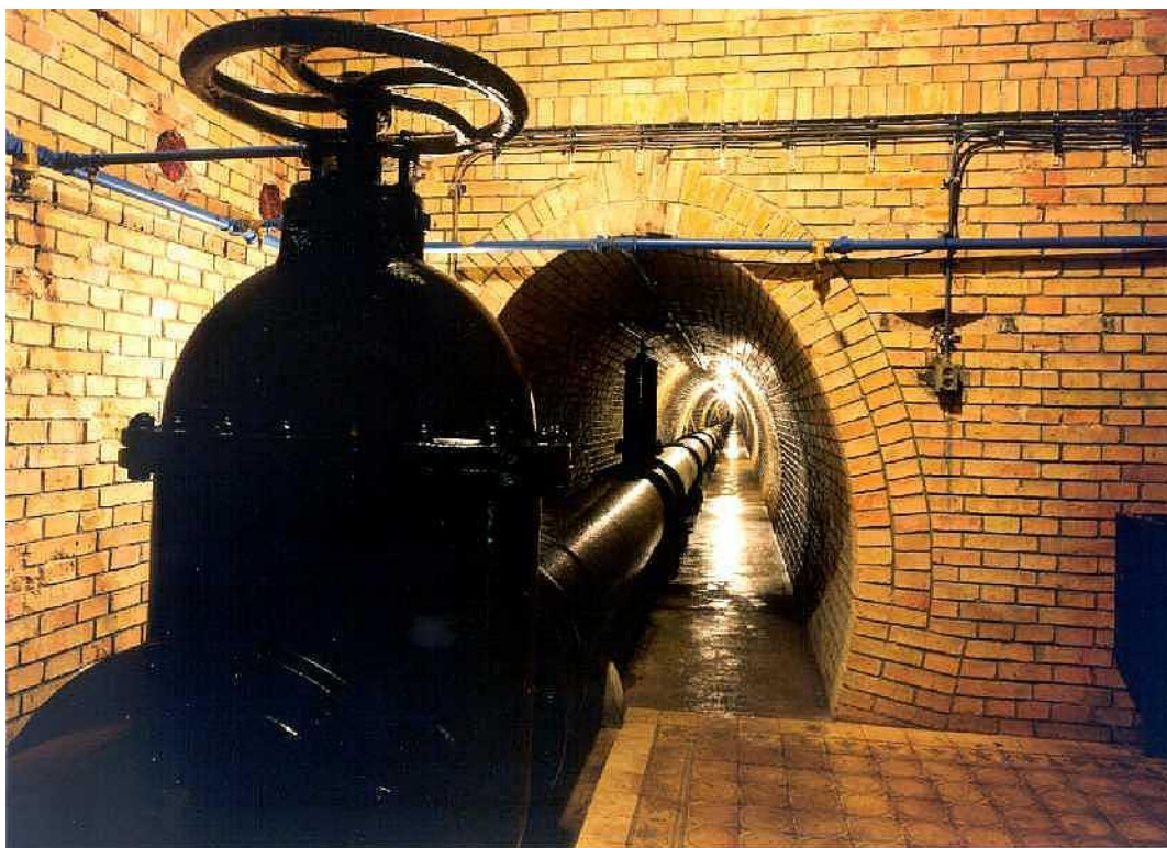
Obr. 2 Štola násosky I. březovského vodovodu v prameništi Březová nad Svitavou [7]
