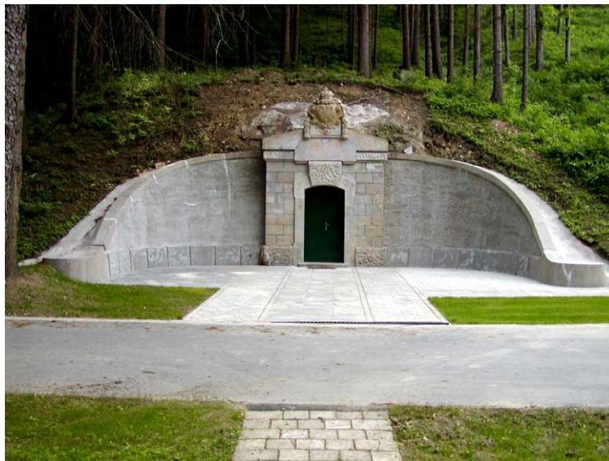
Obr. 3 Portál štoly násosky I. březovského vodovodu [7]
