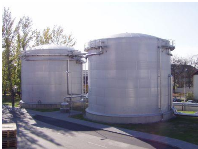
Obr. 6.4: Velkoprostorová nádrž pro skladování kapalin bez tlaku [17]
