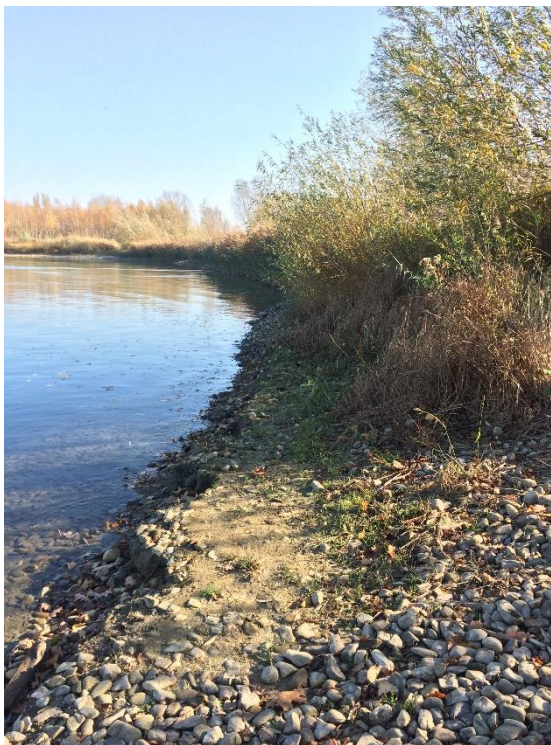
Obr. 18 Stávající stav břehu nádrže
