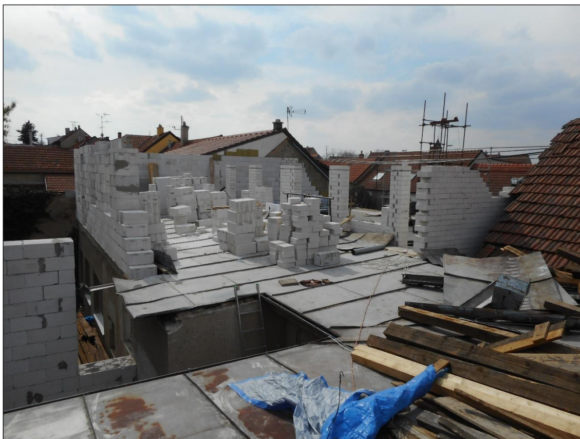
Obr. č. 25 Pokročilá fáze nástavby 2NP, výstavba obvodového nosného zdiva [vlastní]
