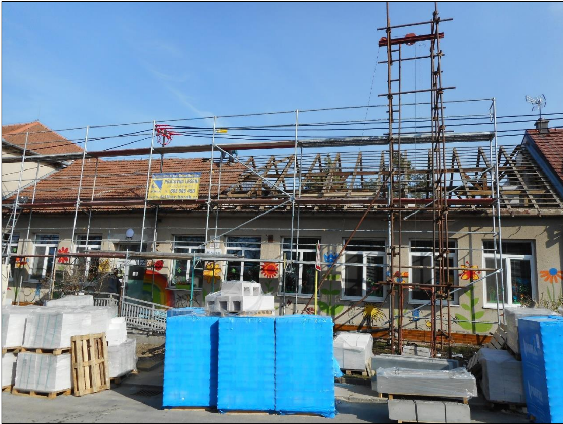
Obr. č. 23 Počáteční fáze demolice původního zastřešení mateřské školy - uliční pohled [vlastní]
