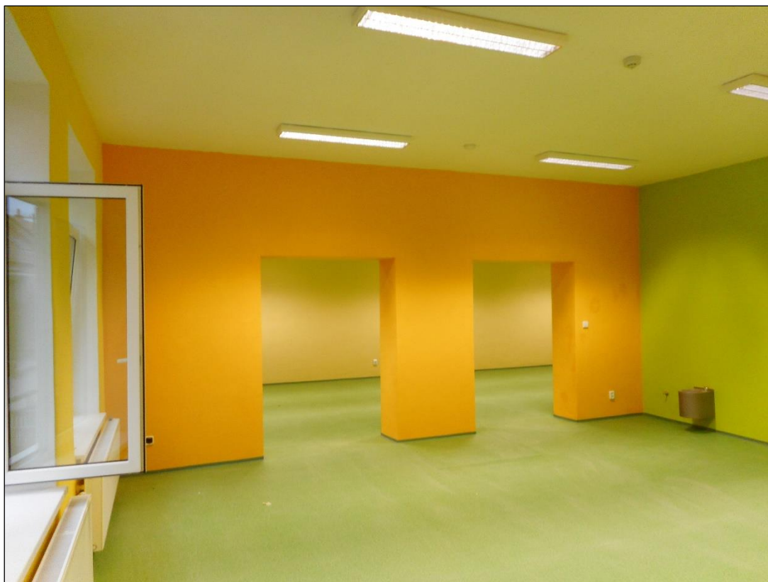
Obr. č. 20 Konečná fáze I. stavební etapy, interiér objektu mateřské školy [vlastní]
