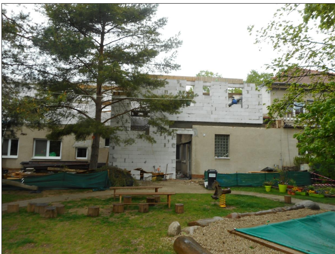
Obr. č. 28 Pokročilá fáze nástavby 2NP a dvorní přístavby mateřské školy – dvorní pohled [vlastní]
