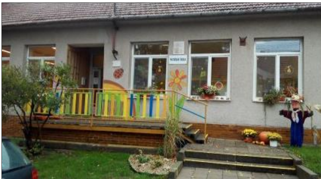
Obr. č. 8 Zobrazení vstupu do Mateřské školy Blažovice z ulice Nová – původní stav před rekonstrukcí [vlastní]
