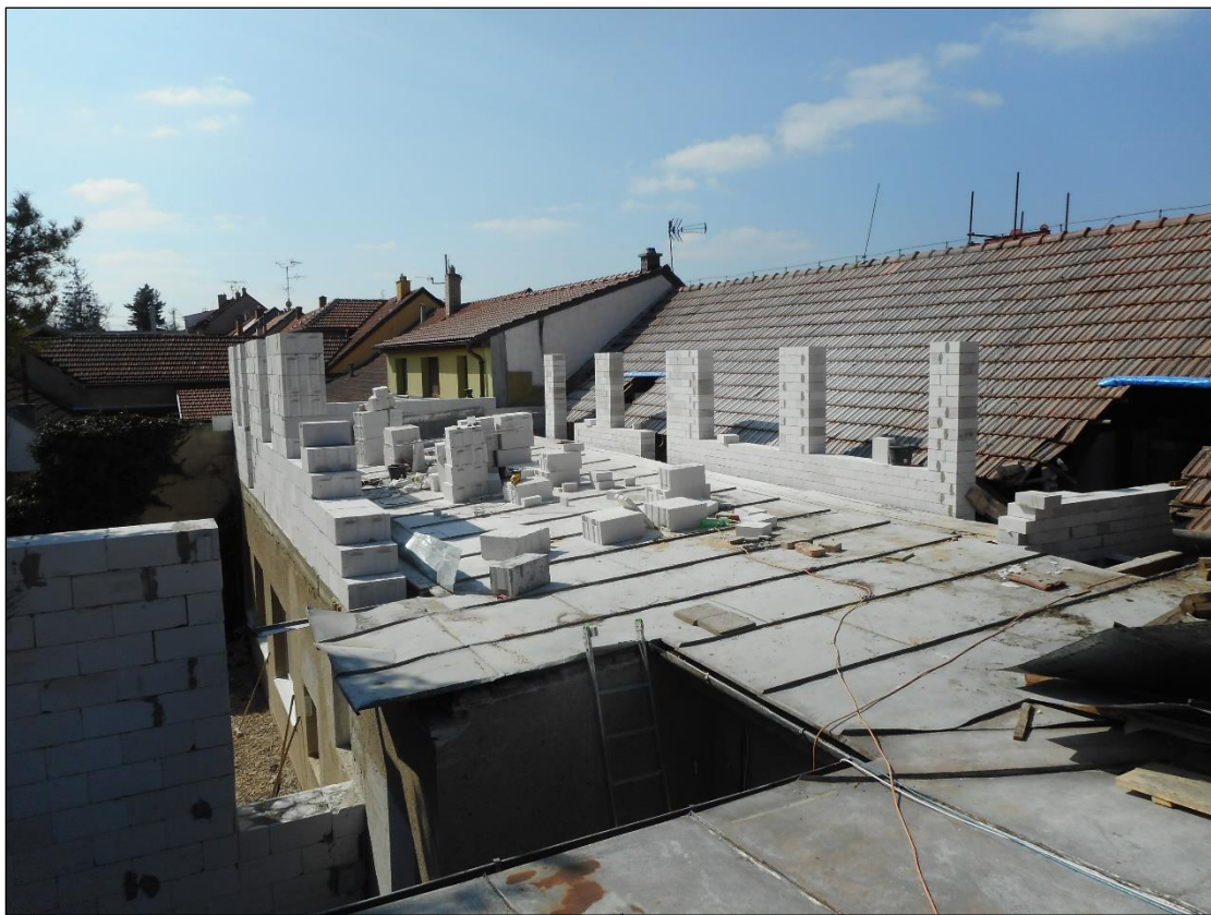
Obr. č. 24 Počáteční fáze nástavby 2NP - pohled ze stavby [vlastní]
