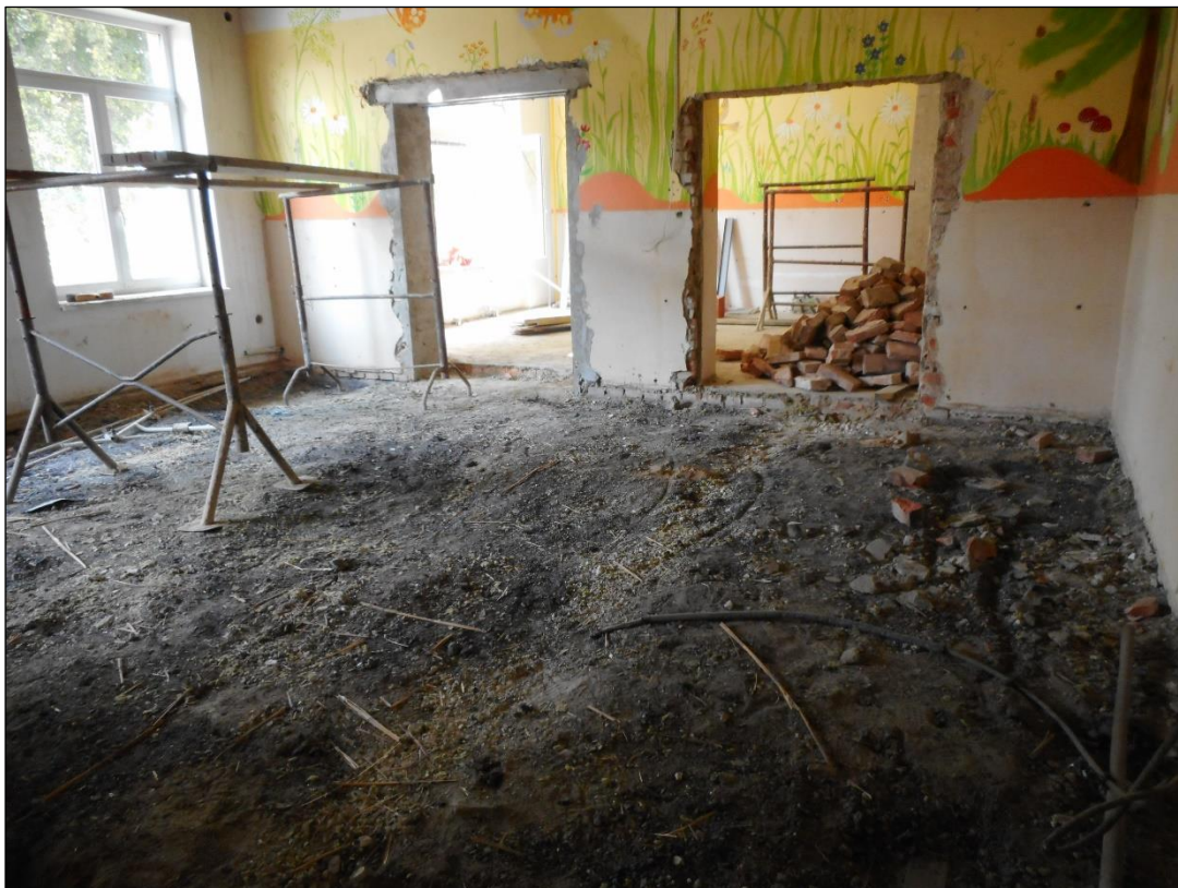
Obr. č. 15 Počáteční fáze rekonstrukce interiéru mateřské školy [vlastní]
