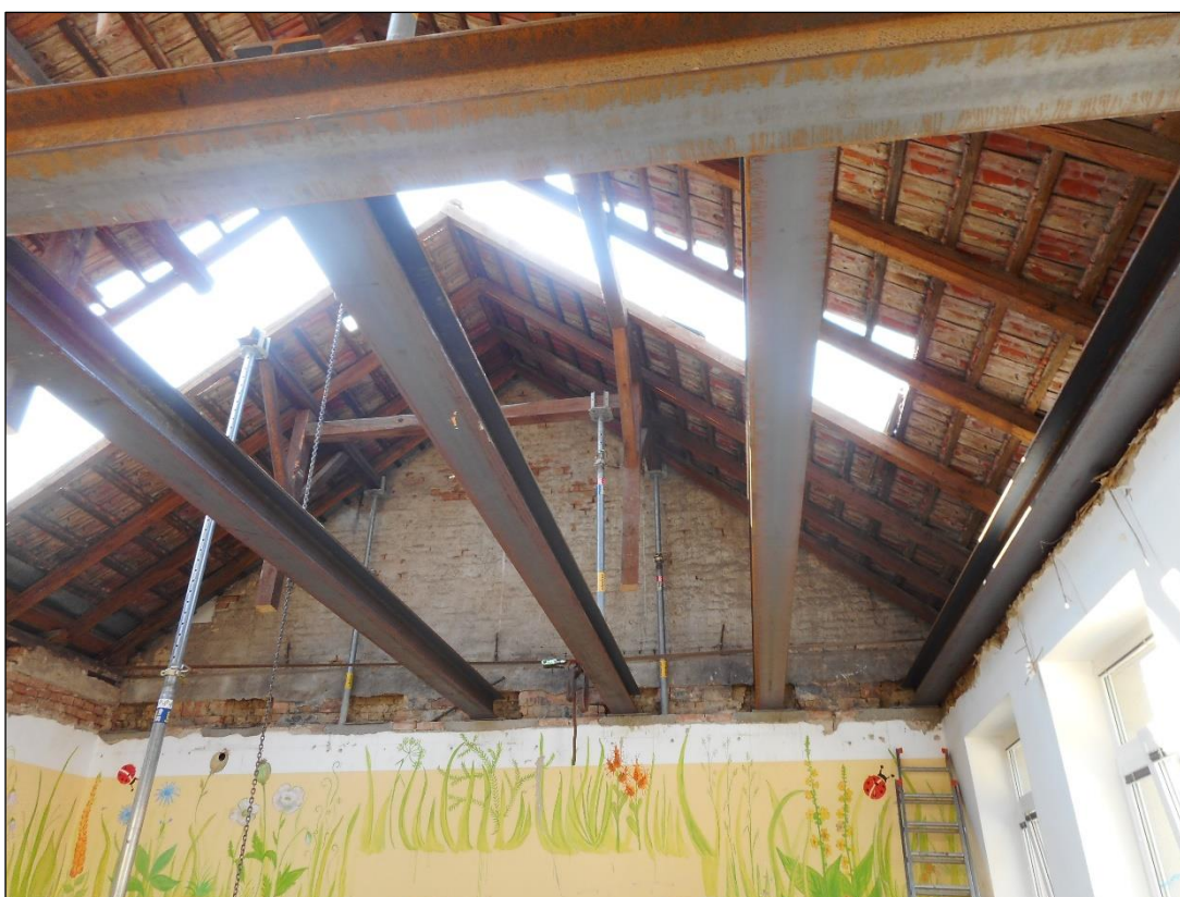
Obr. č. 16 Výměna dřevěných trámových stropů v 1NP, příprava ocelových stropnic a průvlaků podporovaných sloupky a pilíři [vlastní]
