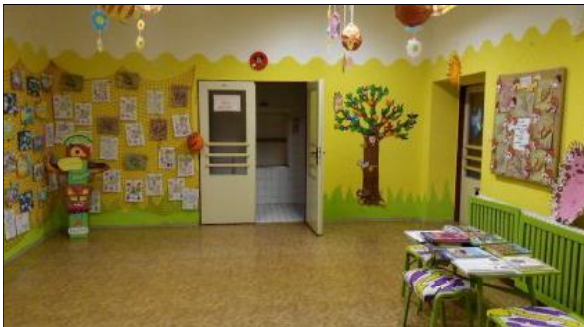
Obr. č. 9 Zobrazení interiéru mateřské školy, vstupní hala – původní stav před rekonstrukcí [vlastní]
