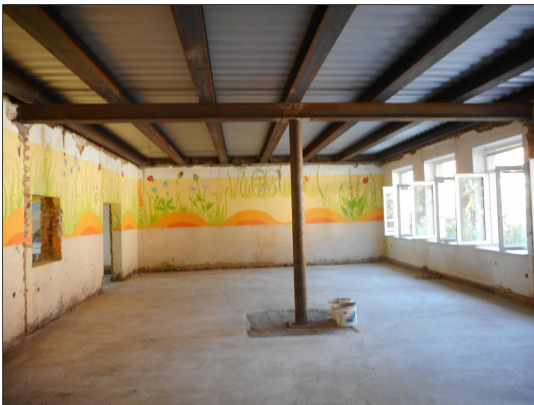
Obr. č. 17 Nová ocelová konstrukce na trapézovém plechu s ocelovými stropnicemi [vlastní]
