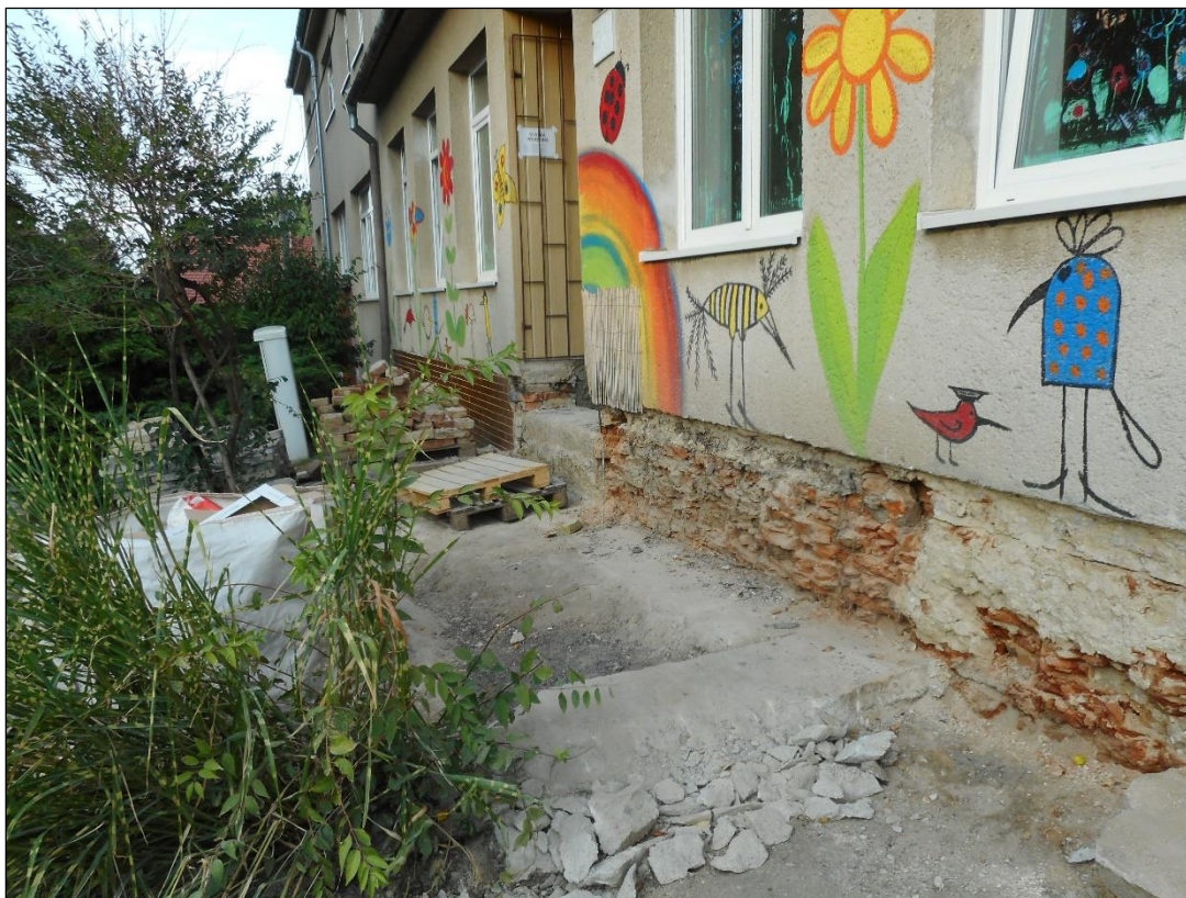
Obr. č. 21 Vybourání hlavní přístupové komunikace do objektu [vlastní]
