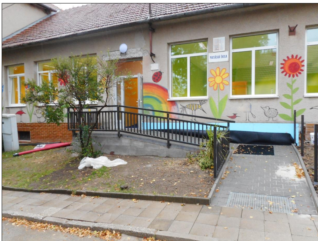
Obr. č. 22 Úprava uličního vstupu, nově vybudovaná bezbariérová rampa [vlastní]
